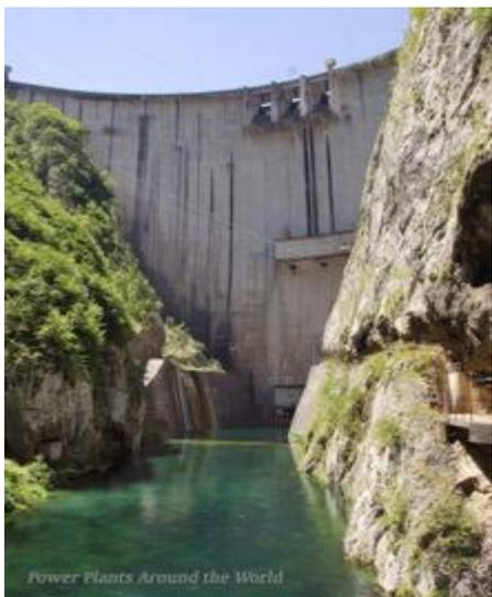
Visina brane je 59 m, a za regulisano ispuštanje vode iz akumulacije koriste se dva temeljna ispusta u tijelu brane prečnika  $\varnothing$  1200 mm. Temeljni ispusti su smješteni u centralnom dijelu brane, sa osovinom na koti 806,00 mm.
