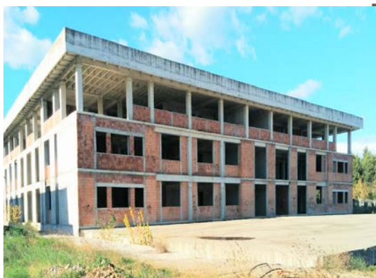
Slika 1 – postojeće stanje objekta
