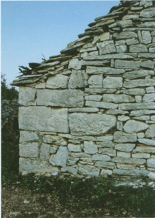
Ugao i struktura zida suhozidne kućice.
