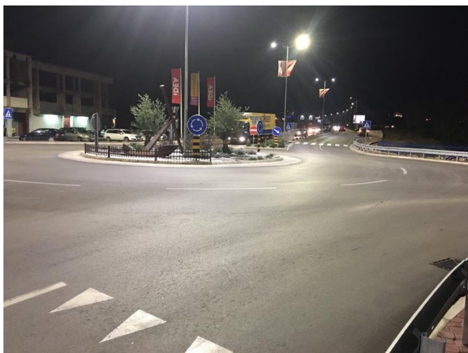
Slika 2.1: Novoizgrađeni kružni tok u blizini lokacije na kojoj se vršilo brojanje saobraćaja
