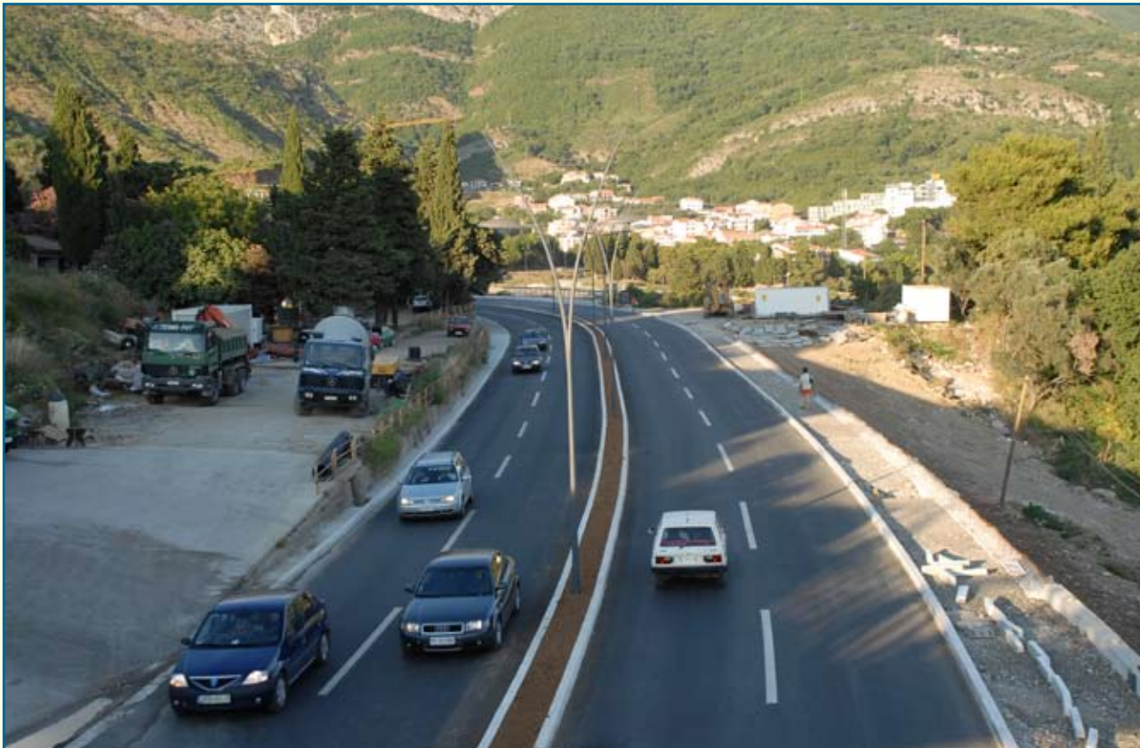
Bulevar u Bečićima nakon rekonstrukcije (2 km), Program rješavanja uskih grla, 2007 - 2009. god.
