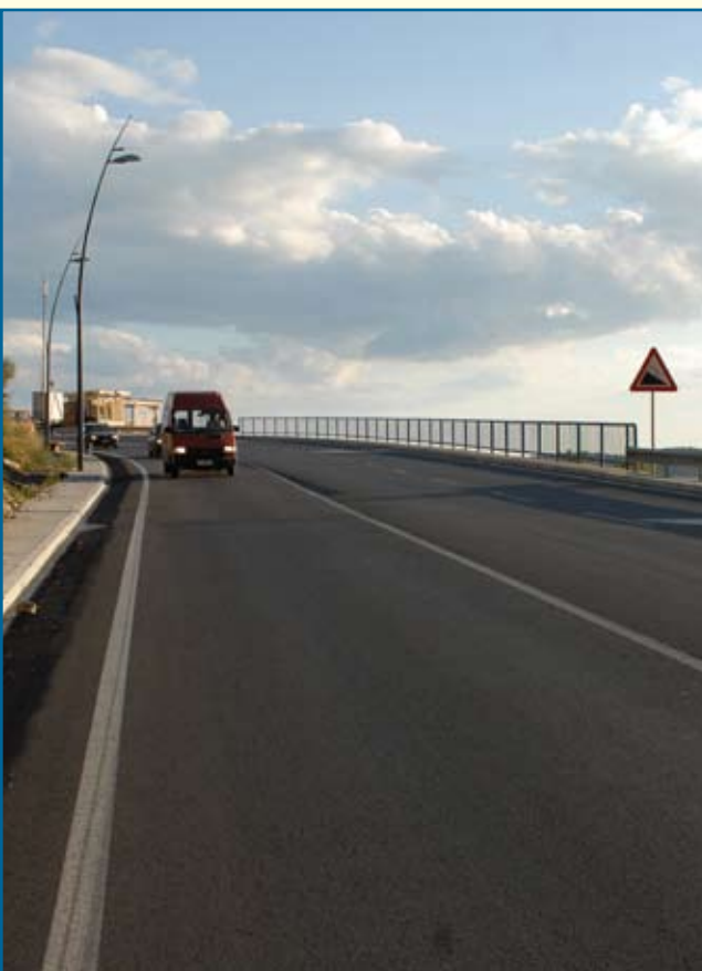
Novoizgrađena treća traka za sporu vožnju lokalitet Rafailovići (2 km) na putu Petrovac Budva, Program rješavanja uskih grla, 2007 - 2009. god.
