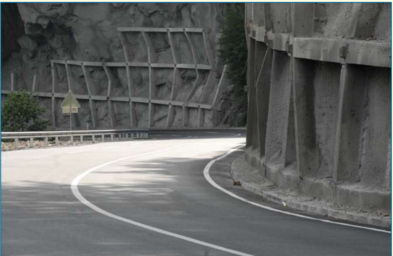
Dionica Mioska Kolašin, sanirana kosina, Program saniranja kritičnih tačaka, 2005 - 2007. god.
