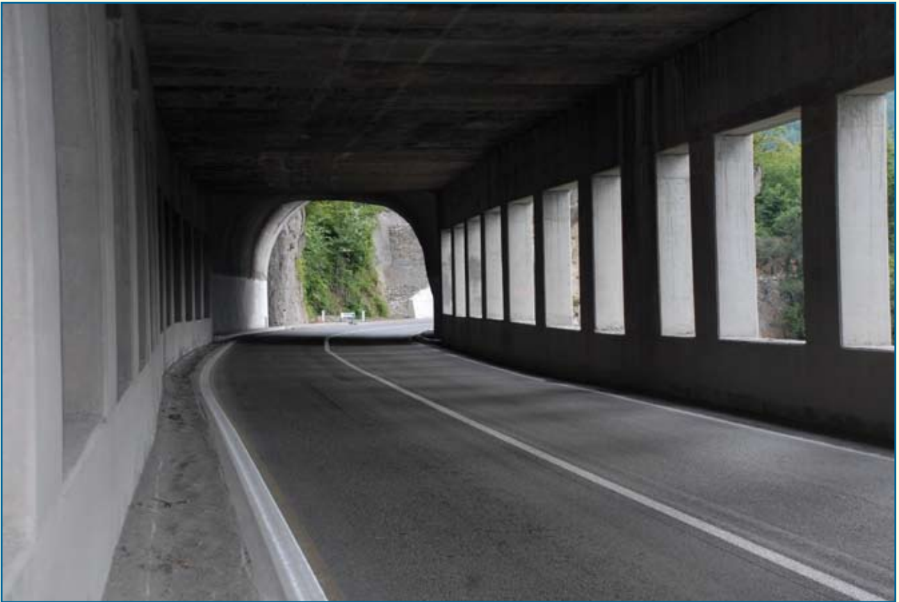
Zaštitna galerija i tunel na dionici Mioska Kolašin
