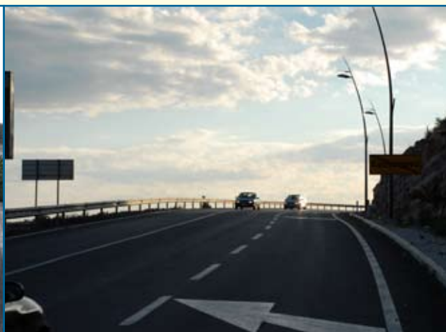
Novoizgrađena treća traka za sporu vožnju lokalitet Rafailovići (2 km) na putu Petrovac Budva Program rješavanja uskih grla, 2007 - 2009. god.
