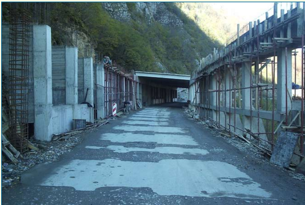
Bakovića klisura, na putu Podgorica Kolašin u toku izgradnje zaštitne galerije, Program saniranja kritičnih tačaka, 2005 – 2007. god.
