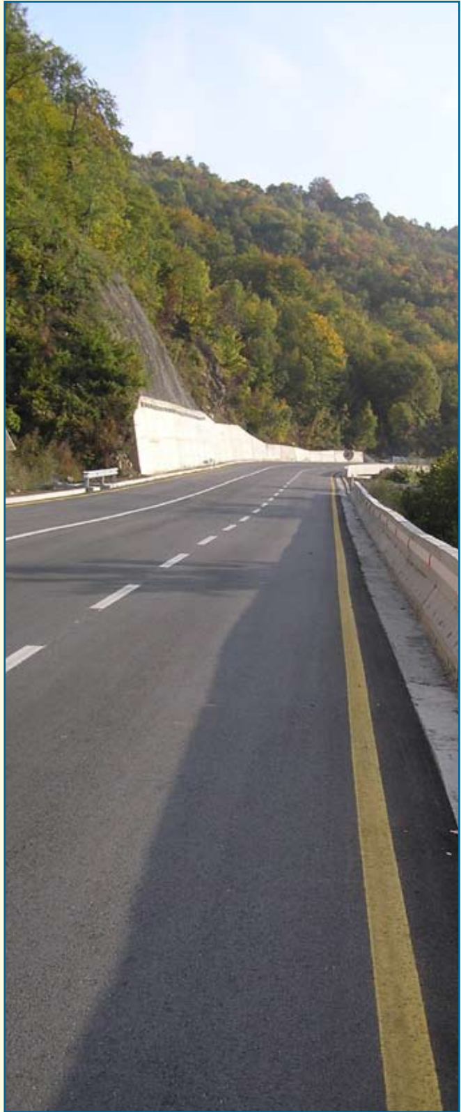
Dionica Dolovi (900 m) na putu Podgorica Kolašin, izrađena treća traka za sporu vožnju, Program saniranja kritičnih tačaka, 2005 - 2007. god.
