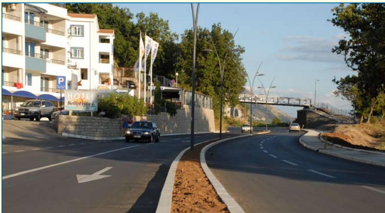
Bulevar u Bečićima nakon rekonstrukcije (2 km), Program rješavanja uskih grla, 2007 - 2009. god.
