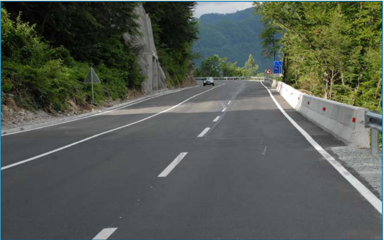
Dionica Mioska Kolašin, 6 km, rehabilitacija asfalnog kolovoza, Program saniranja kritičnih tačaka, 2005 - 2007. god.
