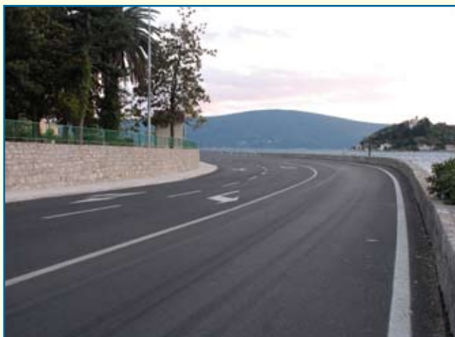
Novoizgrađena treća traka na lokalitetu Lepetani (500 m), na putu Tivat Herceg Novi, Program rješavanja uskih grla, 2007 - 2009. god.
