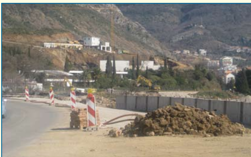
Radovi na izgradnji bulevara u Bečićima, program rješavanja uskih grla, 2007.-2009.god.
