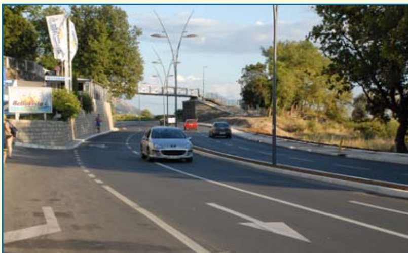
Bulevar u Bečićima nakon rekonstrukcije (2 km), Program rješavanja uskih grla, 2007 - 2009. god.
