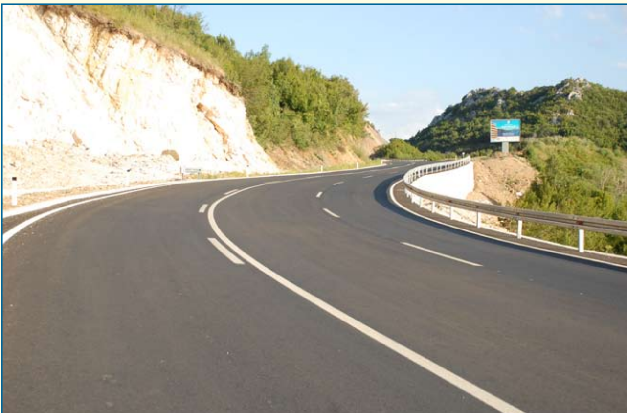
Lokalitet Kufin (4,6 km) na putu Bar Petrovac, izgrađena treća traka za sporu vožnju, Program rješavanja uskih grla, 2007 - 2009. god.
