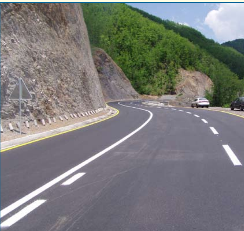
Dionice Seoca I ( 550 m ) i Seoca II ( 1450 m ) na putu Podgorica Kolašin, izgrađene treće trake za sporu vožnju, Program saniranja kritičnih tačaka, 2005 - 2007. god.
