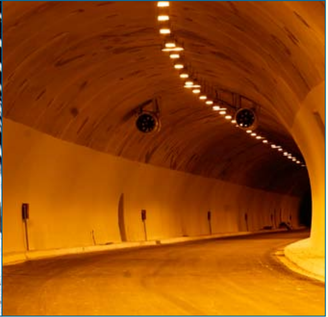
Tunel Vrmac nakon sanacije, Program sanacije kritičnih tačaka, 2005 - 2007. god.
