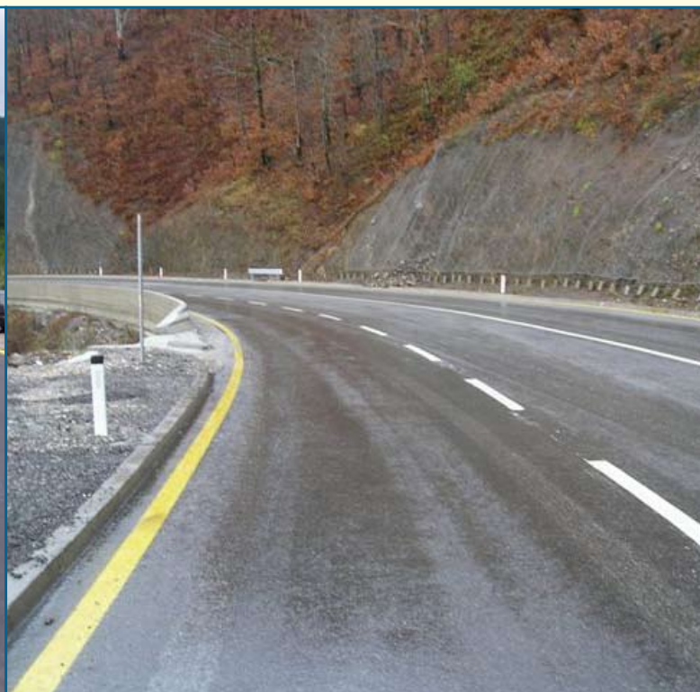
Dionice Seoca I ( 550 m ) i Seoca II ( 1450 m ) na putu Podgorica Kolašin, izgrađene treće trake za sporu vožnju, Program saniranja kritičnih tačaka, 2005 - 2007. god.
