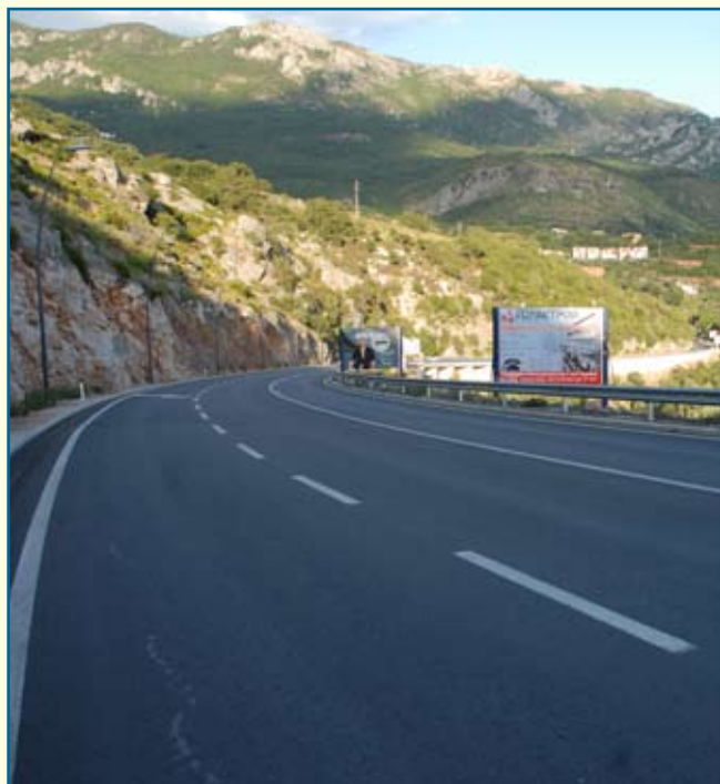
Novoizgrađena treća traka za sporu vožnju lokalitet Rafailovići (2 km) na putu Petrovac Budva, Program rješavanja uskih grla, 2007 - 2009. god.
