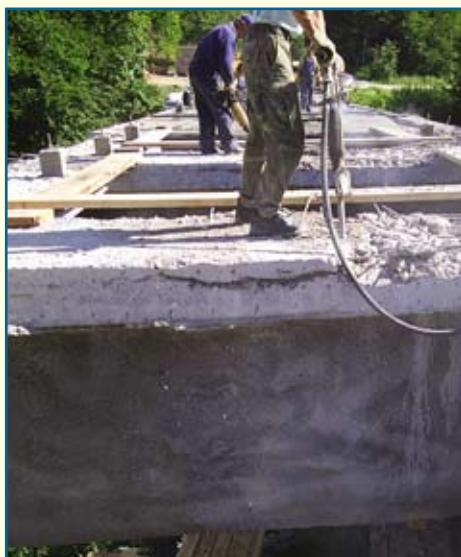
Most Pčinja u toku sanacije, Program zaostalog održavanja
