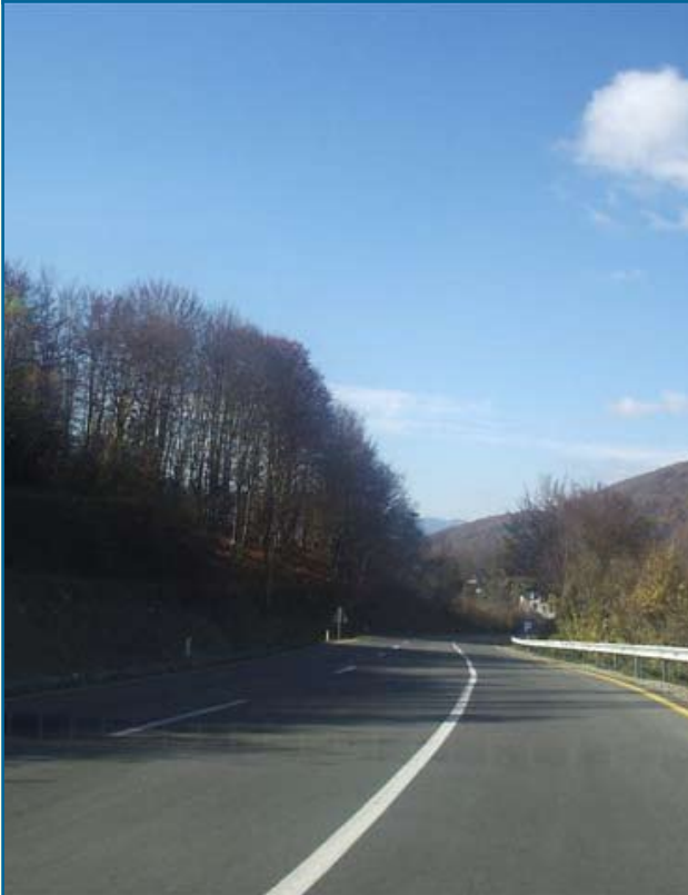
Dionica Krstac kod Mojkovca , rekonstrukcija dijela puta i izgrađena treća traka, Program saniranja kritičnih tačaka, 2005 - 2007. god.
