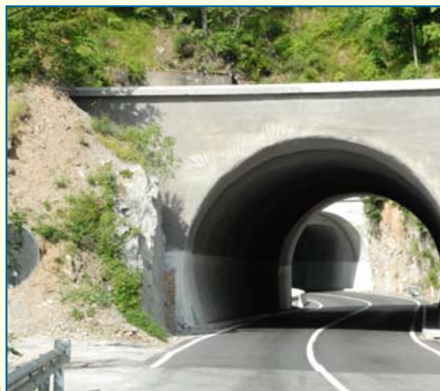
Sanirani tuneli na dionici Mioska Kolašin
