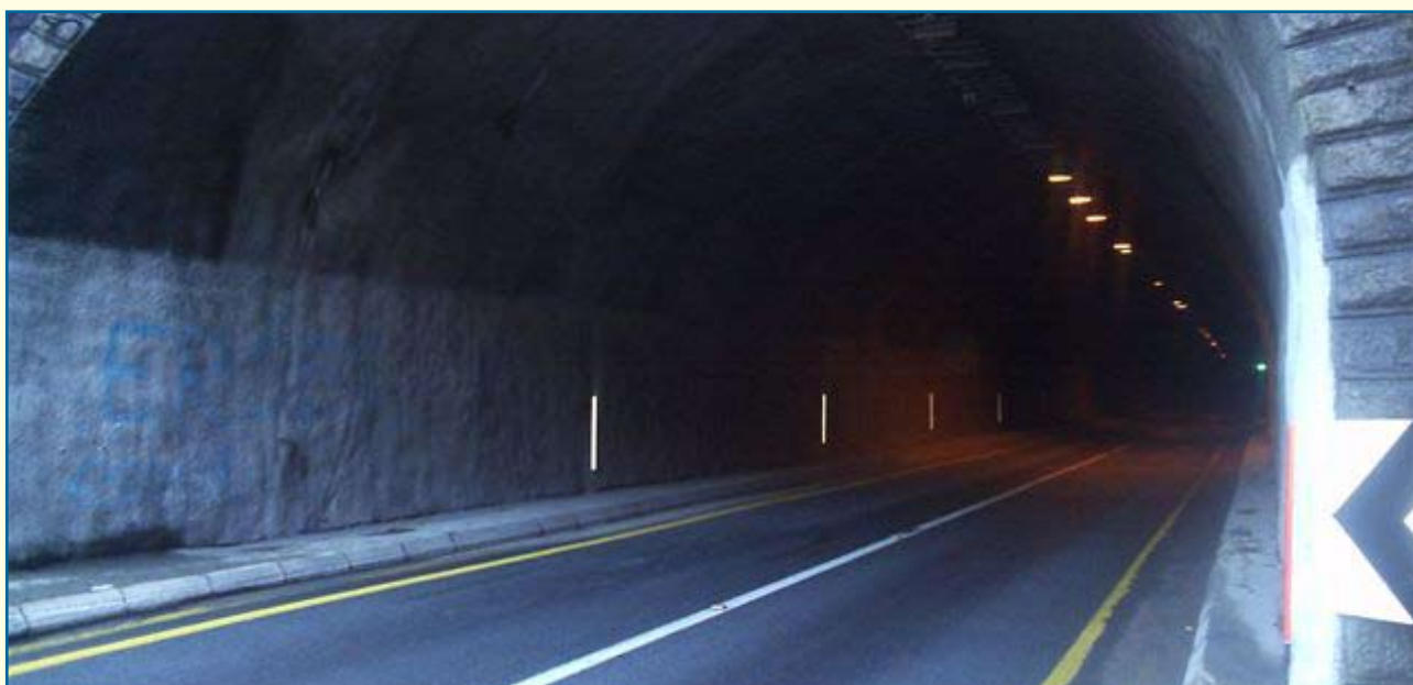
Saniran tunel Lokve na putu Podgorica Berane, Program zaostalog održavanja
