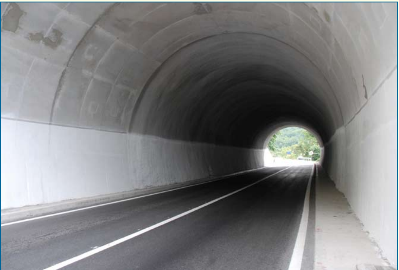
Jedan od saniranih tunela na dionici Mioska Kolašin
