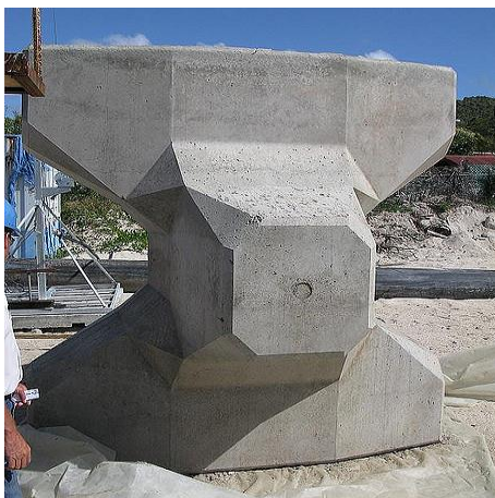
Slika 5. Izgled betonskog bloka tipa akropod
