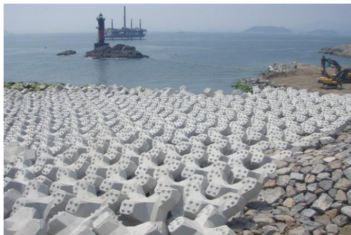
Slika 6. Izgled zaštitne obloge od akropoda u fazi izgradnje lukobrana
