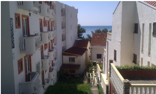
Slika 26: Novogradnja u Sutomoru
