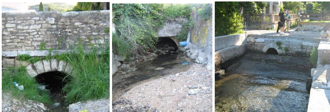
Primjeri propusta kišnih kanala kroz priobalnu saobraćajnicu
