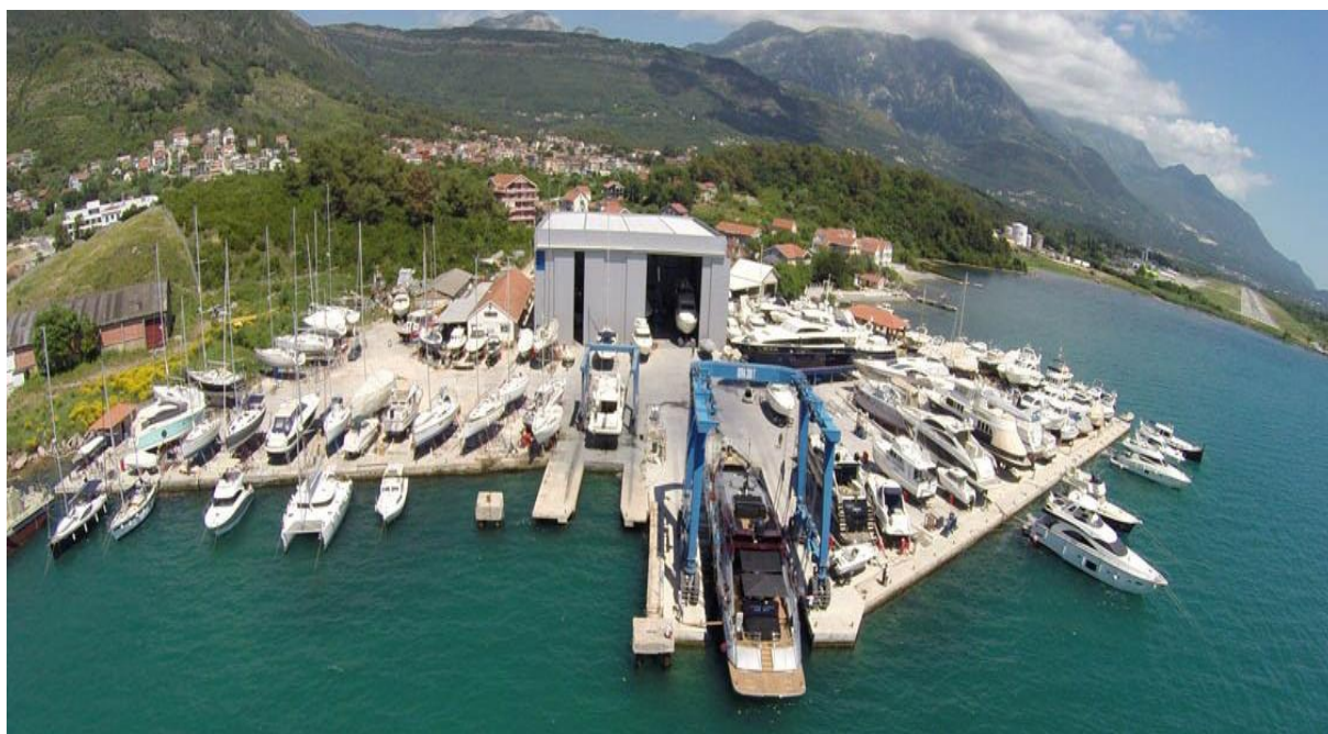
Slika br. 13: Brodogradilišna luka Bonići
