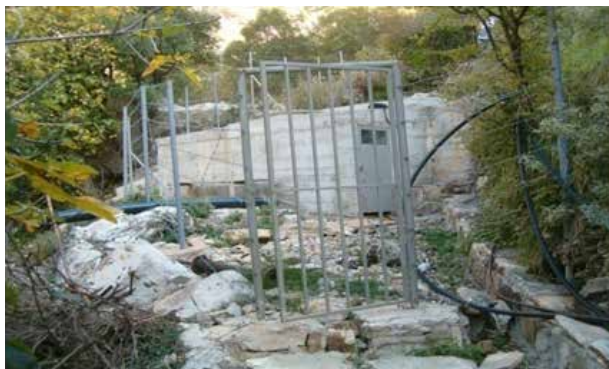
Slika 1.2/2 Pogled na kaptazu „Vrteljak“
