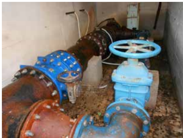
Slika 1.2/16 Šahta sa mjeracima protoka na izvorištu Kajnak
