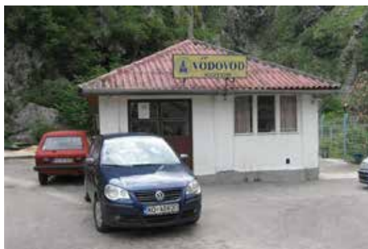
Slika 1.10/2 Pumpna stanica Tabačina
