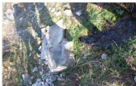
Prelivanje na priključnom šahtu izvorišta Brajša i PS Lisna Bori
