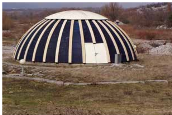
Slika 1.7/8 Kaptažna građevina izvorišta Marezha
