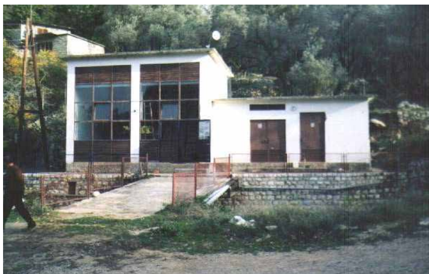
Slika 1.2/7 Pogled na objekte iznad kaptaže “Brca”
