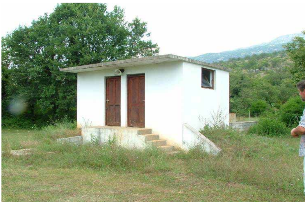
Slika 1.7/5 Crpna stanica Brajovića Jama
