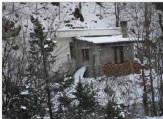
Slika 1.9/6: Sabirna komora i hlorinatorska stanica
