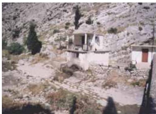
Slika 1.2/6 Pogled na objekte iznad kaptaze „Kajnak“
