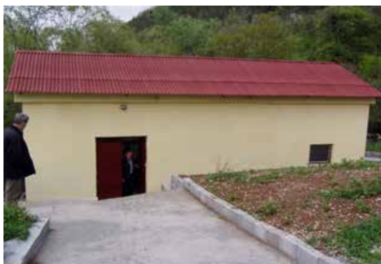
Slika 1.7/7 Crpna stanica Milojevića vrelo
