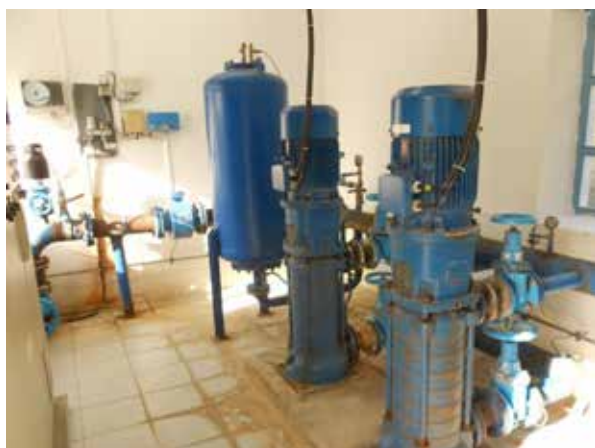
Slika 1.2/17 Mjerač protoka i hlorna oprema u pumpnoj stanici Čanj - izvorište Vrelo
