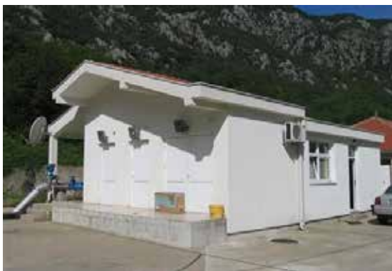
Slika1.10/4 Pumpna stanica tunel Vrmac
