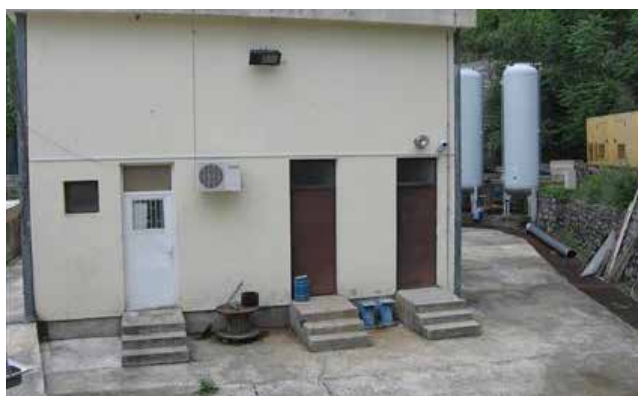
Slika1.10/3 Pumpna stanica Orahovac
