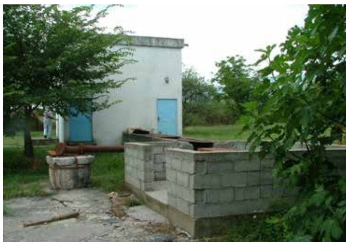
Slika 1.7/4 Crpna stanica Žarića Jama
