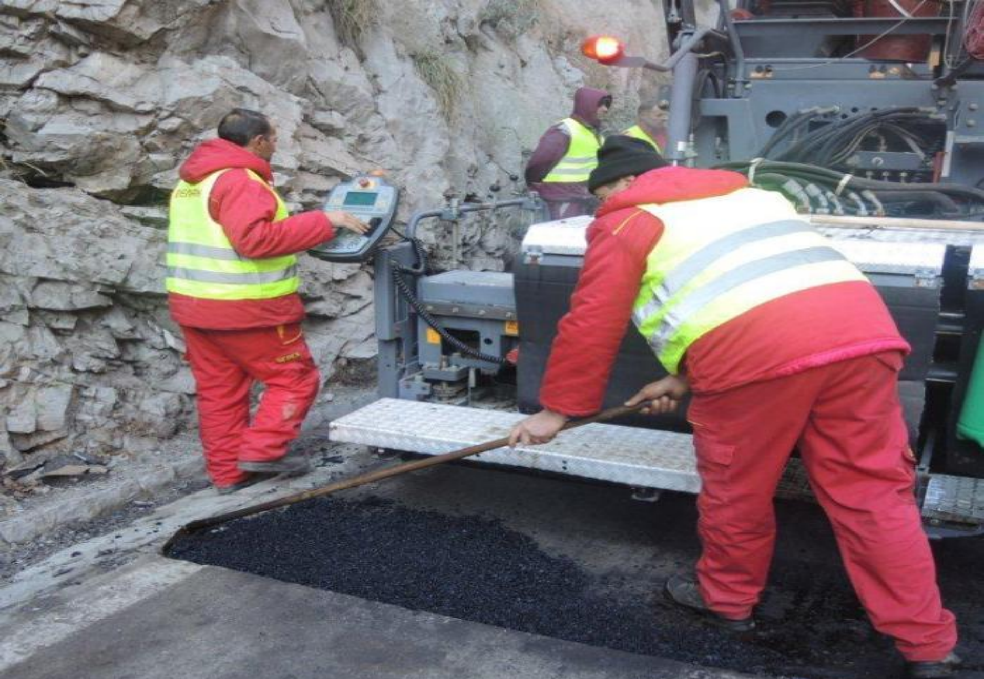
Završena sanacija tri tunela na magistralnom putu Podgorica – Kolašin
