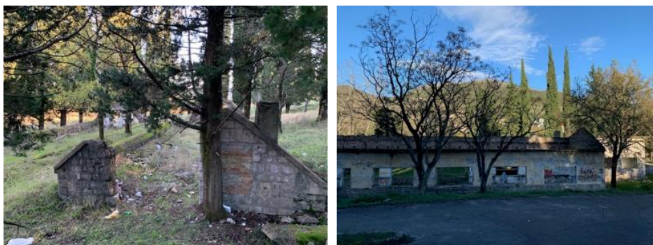
Fotografije postojećih objekata
