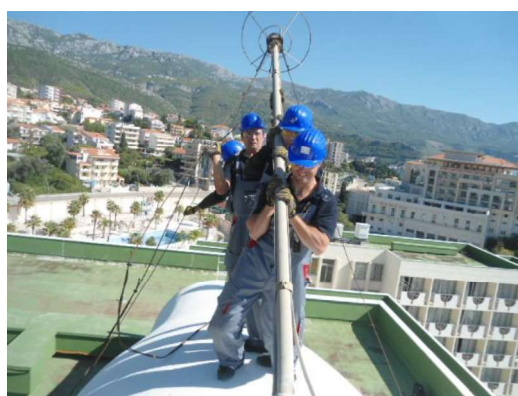
Slika 17 Uklanjanje gromobrana sa hotela Mediteran u Bečićima
