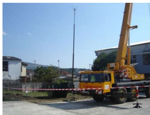
Slika 3 Uklanjanje gromobrana sa OŠ „Maršal Tito“ u Ulcinju
