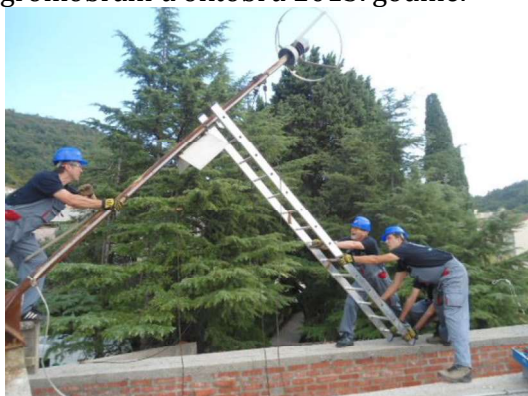
Slika 16 Uklanjanje gromobrana sa hotela Castellastva u Petrovcu
