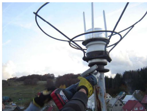
Slika 19 Uklanjanje gromobrana sa stambene zgrade na Žabljaku
