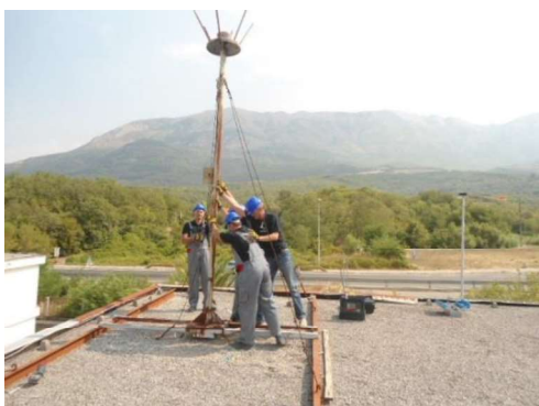
Slika 2 Uklanjanje gromobrana sa OŠ „Nikola Đurković“ u Kotoru
