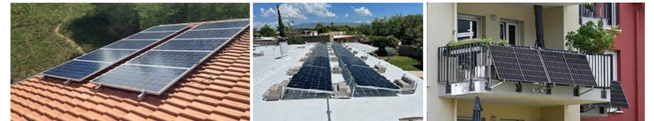
Solarni paneli na krovovima stambenih objekata
