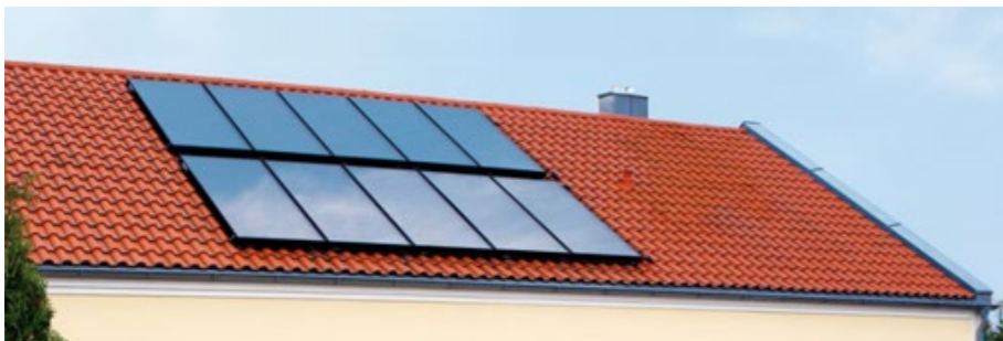
Ravni pločasti kolektori postavljeni na krovu stambenog objekta
