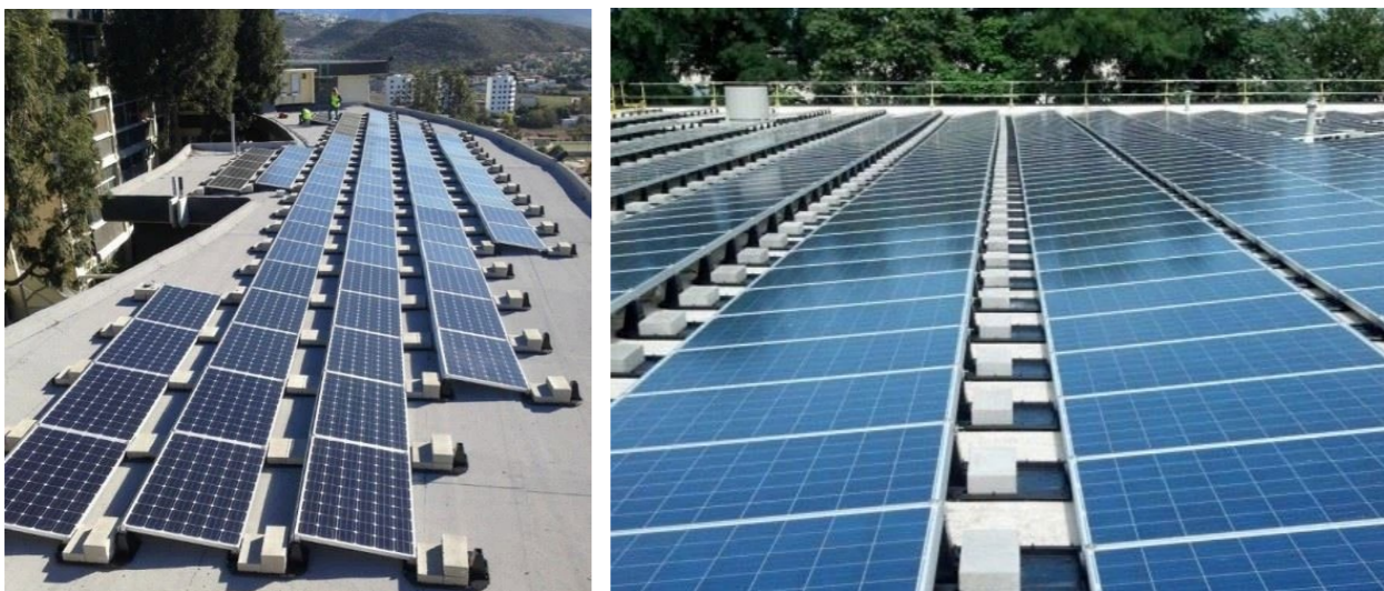
Balastna solarna gradna konstrukcija za ravni krov
