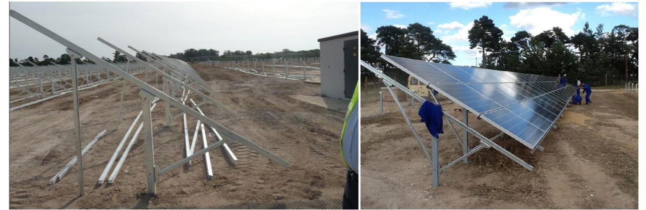
Montaža solarnih panela na zemlji
