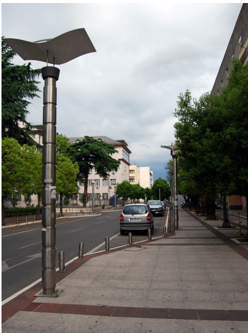
Rekonstrukcija ulice - struktuiranje površine trotoara (Karadžićeva ulice, Podgorica)
