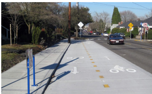
Biciklistička staza u nivou trotoara (gore) i na odvojenom nivou (između ulice i trotoara, dolje)
