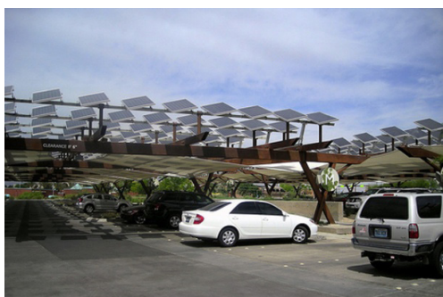
Solarni kolektori – svetiljke i nadstrešnice u javnom prostoru
