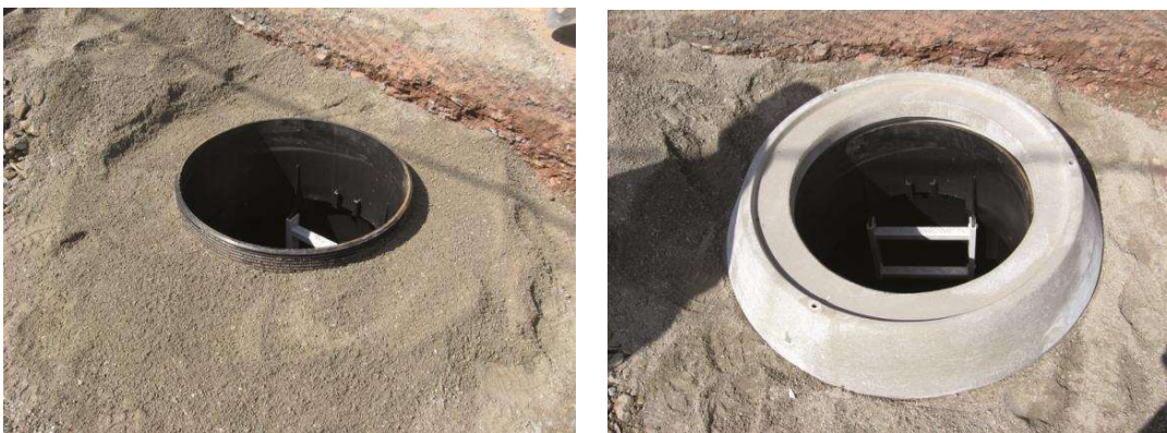
Slika 9 i 10: Postavljanje betonskog prstena za prihvatanje opterećenja
