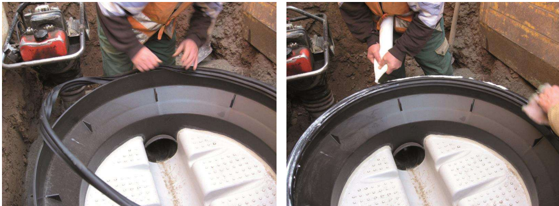
Slika 7 i 8: Postavljanje dihtunga na spoju dva elementa šahta
