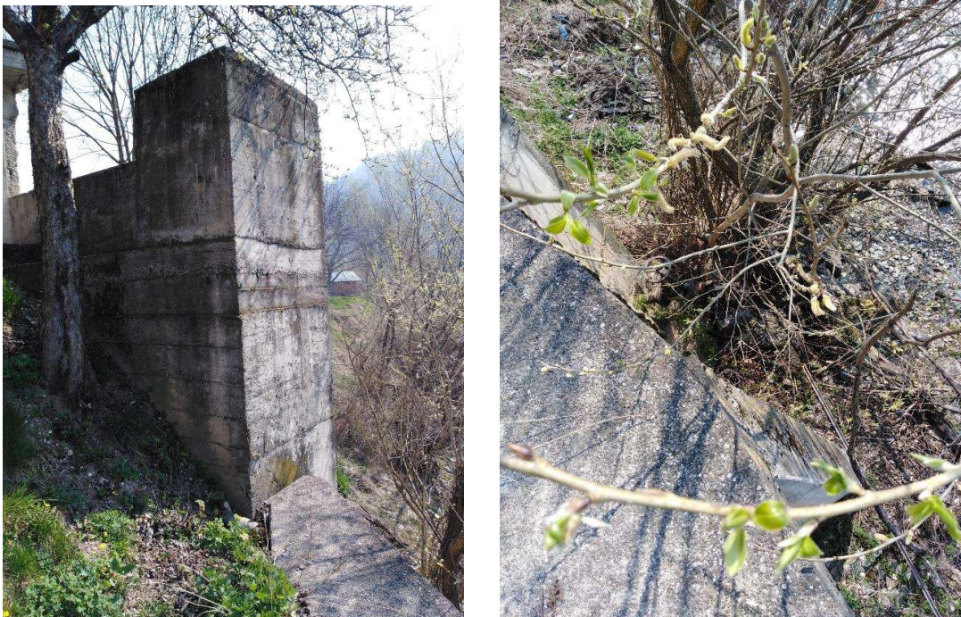
(postojeći ispust iz septičke jame)
