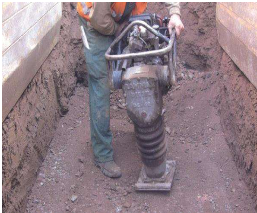
Slika 1 i 2: Priprema podloge za polaganje šahtova
