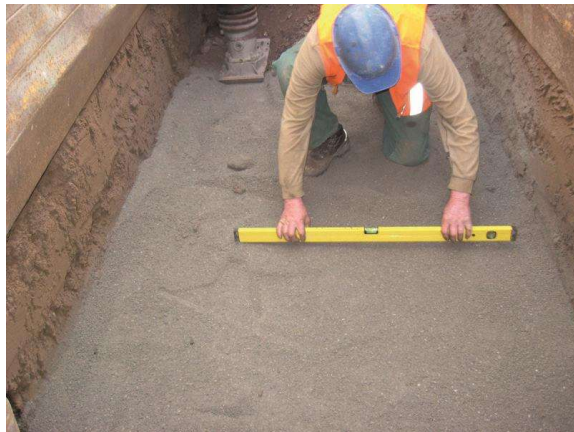
Slika 1 i 2: Priprema podloge za polaganje šahtova
