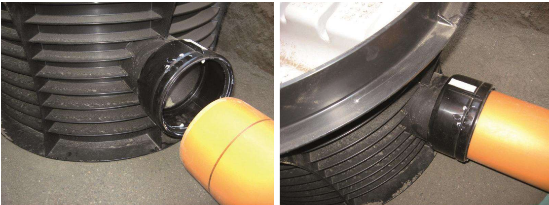
Slika 5 i 6: Izvođenje spoja šahta sa PVC cijevima
