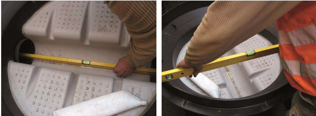
Slika 3 i 4: Kontrola položaja odvoda
