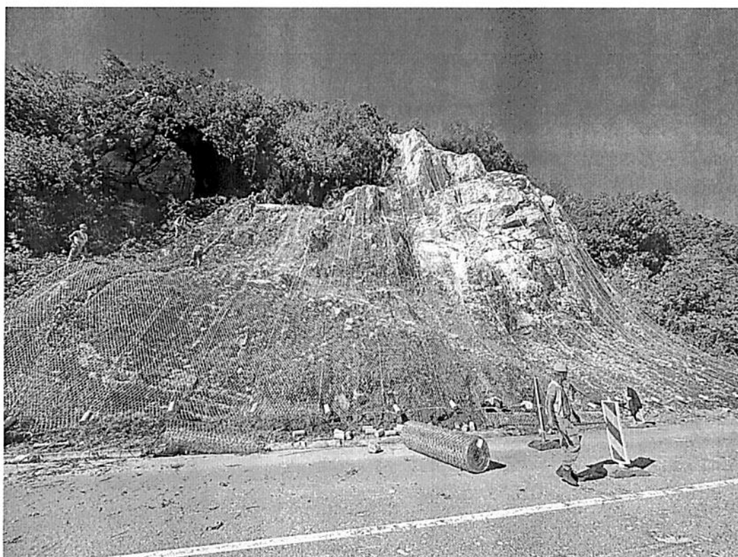
Radovi na postavljanju putarskog pletiva kao jedna od privremenih mjera zaštite kosine od osipanja nakon odrona na magistralnom putu M-10 dionica Cetinje-Budva lokalitet Obzovica km 40+300 (19.09.2025. godine)
