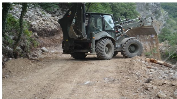
Inženjerija na izgradnji puta u opštini Podgorica
