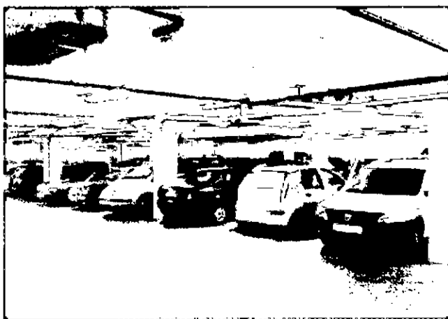
Podzemna garaža u Pljevljima - Foto: Goran Malidžan
