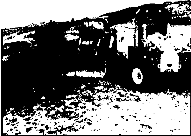
Radovi počeli, uskoro novi put - Foto: Privatna Arhiva
