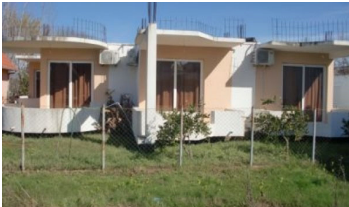
Slika: Izgrađeni objekti
