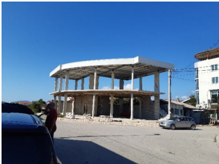
Slika: Izgrađeni objekti
