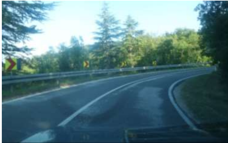
Slika II-9: Nedovoljna horizontalna preglednost (Izvor: T. Tollazzi)
