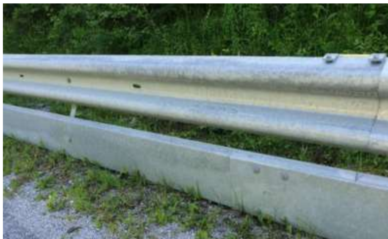
Slika I-30: Pravilna ugradnja dodatne ploče/table za motocikliste (Izvor: T. Tollazzi)
