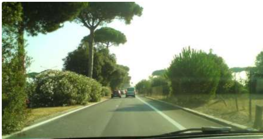
Slika II-2: Preširok kolovoz (Izvor: T. Tollazzi)
