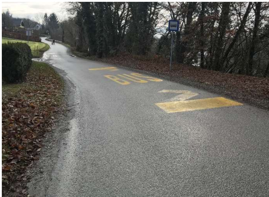
Slika I-15: Autobuska stanica na kolovozu bez pješačke staze i pješačkog prelaza (Izvor: A. Erjavec)
