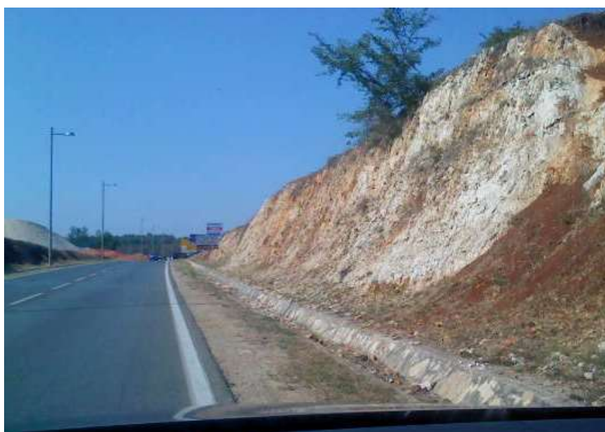
Slika II-5: Opasan kanal za odvodnju (Izvor: T. Tollazzi)
