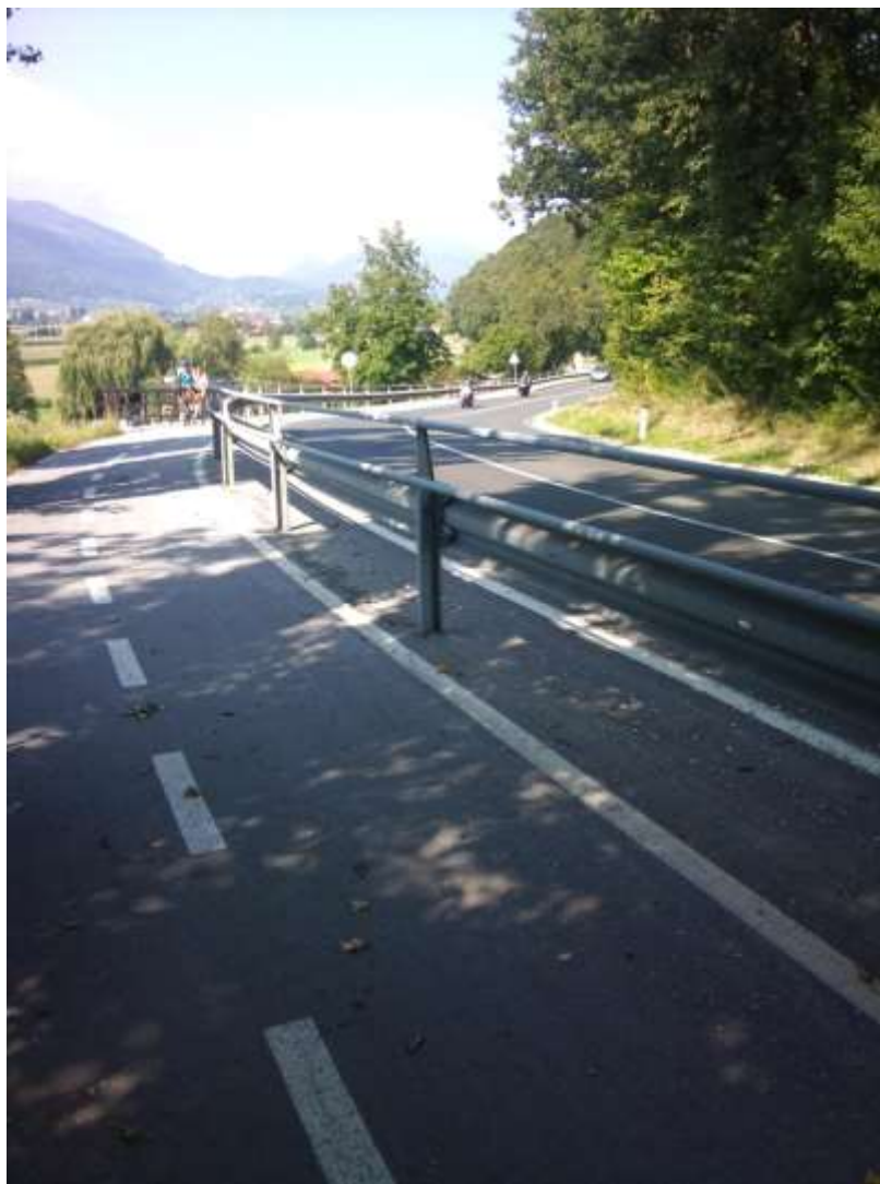
Slika II-22: Zaštitna ograda za bicikliste je opasna za motocikliste (Izvor: T. Tollazzi)
