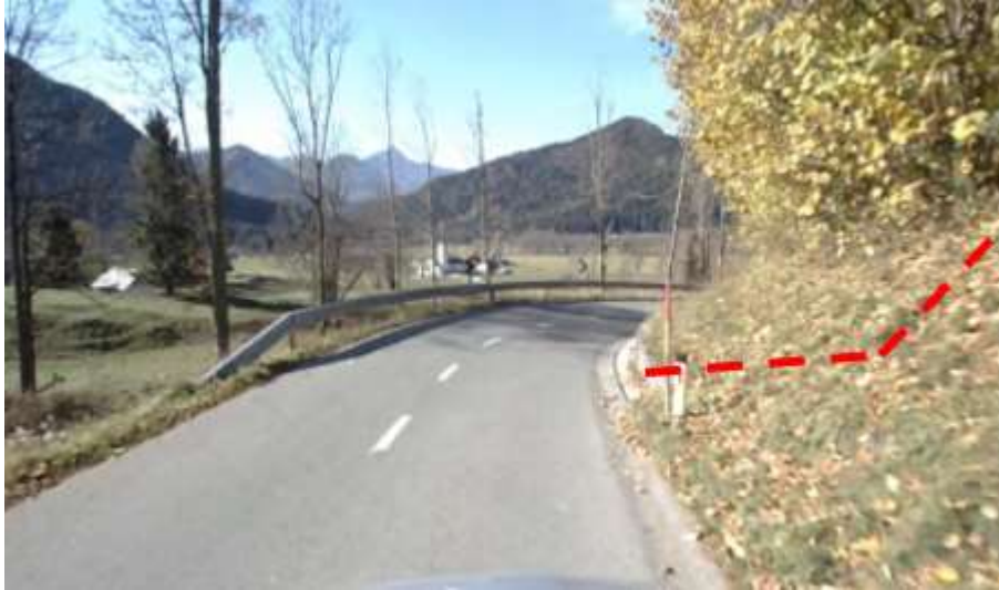
Slika I-1: Nedovoljna horizontalna preglednost (Izvor: T. Tollazzi)
