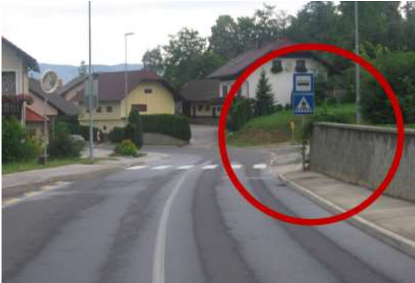
Slika II-11: Smanjena preglednost na priključku zbog zida
