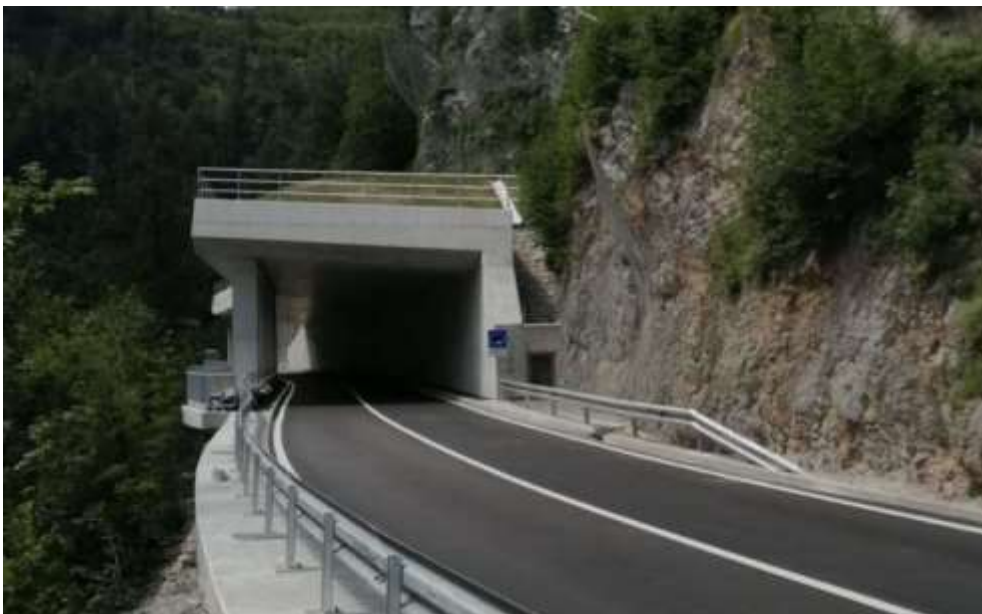
Slika 4-7: Putna galerija za zaštitu od padajućeg kamenja i lavina (Izvor: T. Tollazzi)
