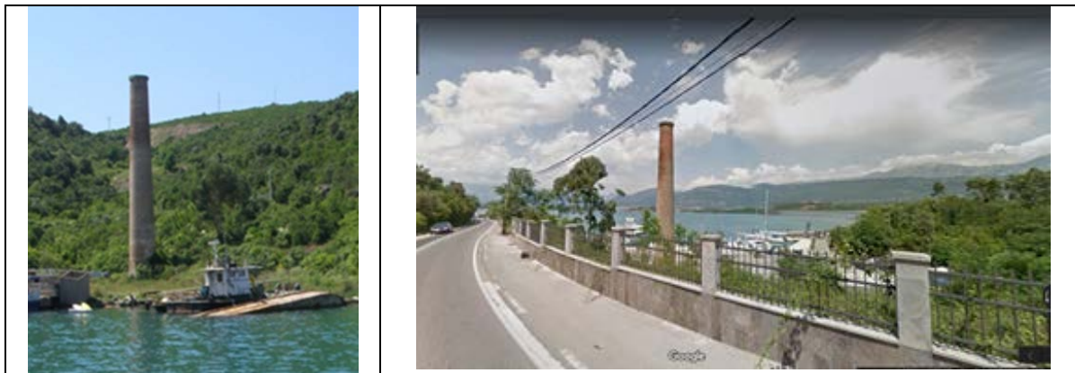
Dimnjak stare fabrike crijepa
