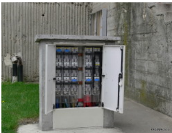
Slika 7: Izgled niskonaponskog razvodnog ormara sa 6 izvoda »NKRO6«
