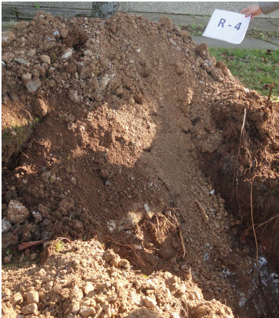
Materijal iz istražnog raskopa Rp-4
