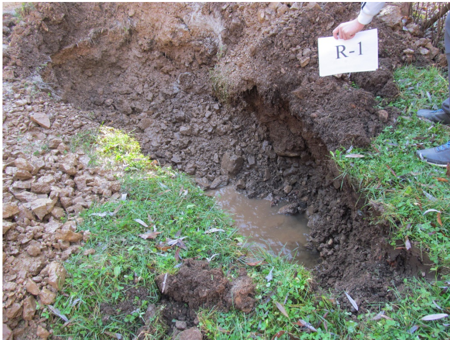
Istražni raskop Rbr-1
