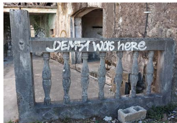
Recentna betonska ograda na ulazu
