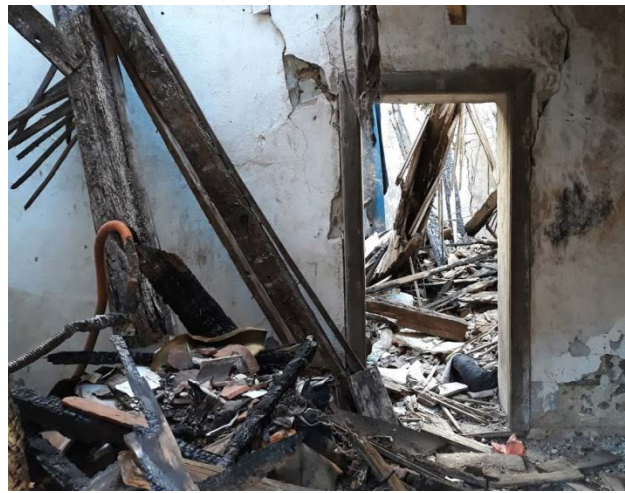
Detalj vrata sa drvenim okvirom u zidu od bondruka
