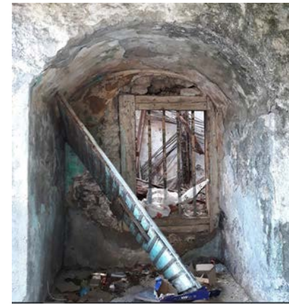
Prozorski otvor a drvenim okvirima
