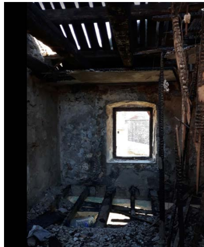
Detalji krovne i plafonske konstrukcije
