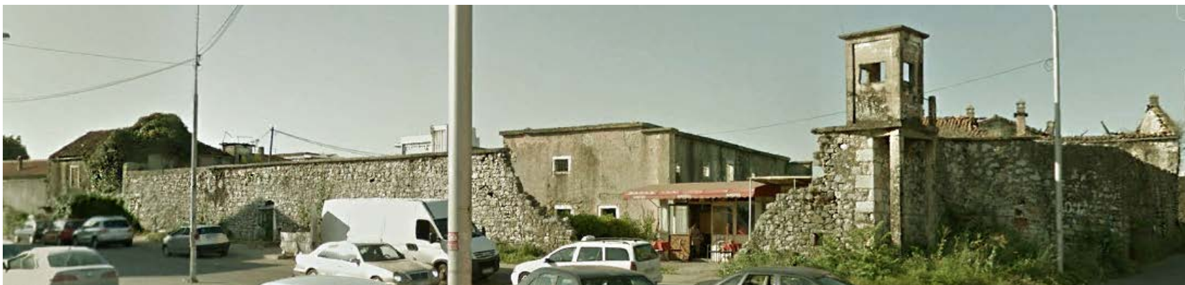
Sjeverni ogradni zid, mart 2020.
