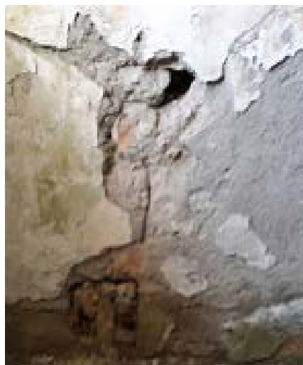
Zidovi od lomljenog kamena sa oslabljenim jezgrom
