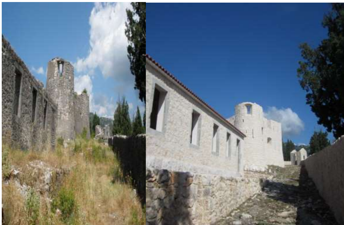
Izgled utvrđenja prije i nakon restauratorskih radova izvedenih 2013. godine
