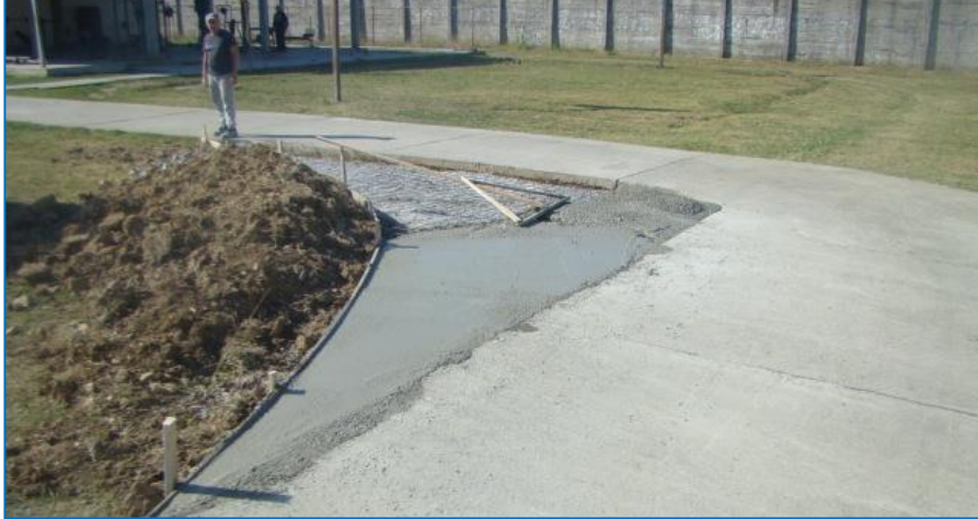
Slika br.31-Izrađene nove i proširane postojeće trotoarske staze kod Upravne zgrade II , u KPD-u i Zatvoru za kratke kazne
