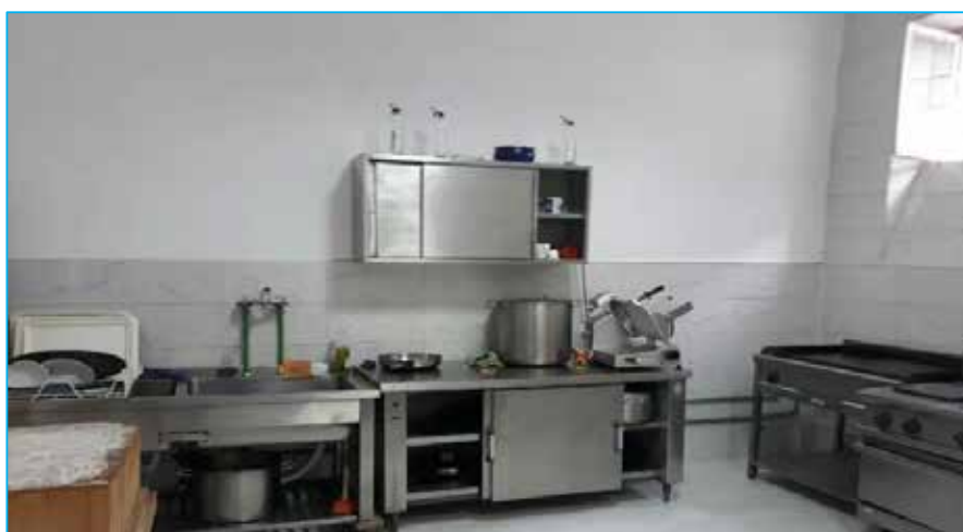
Slika br.47-Zatvorska kuhinja u BP je izmještena iz postojeće prostorije u novu u cjelosti renoviranu prostoriju prilagodjenu za te namjene
