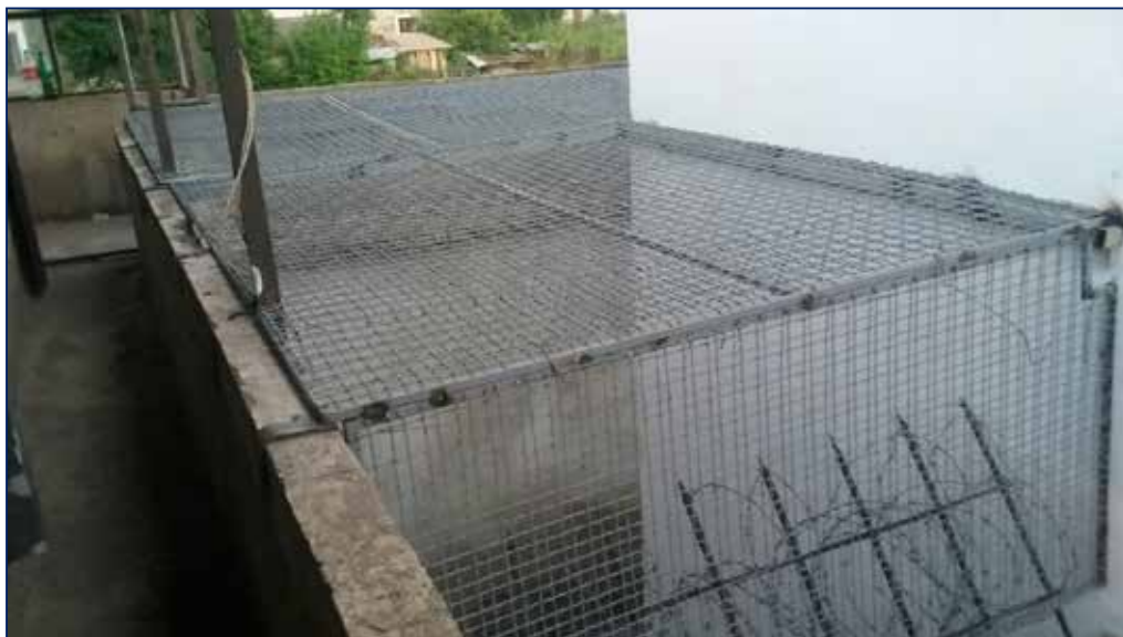
Slika br.46-Izvršena zamjena sitne čelične mreže iznad šetališta Poluotvorenog odjeljenja, površine 100 m 2 , kako bi se spriječilo ubacivanje nedozvoljenih stvari i predmeta iz spoljašnjosti.
