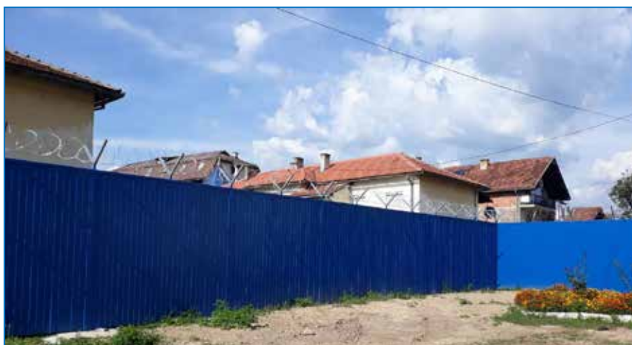
Slika br.42-Izgrađena je montažna metalna ograda visine 3m u dužini od 75m
