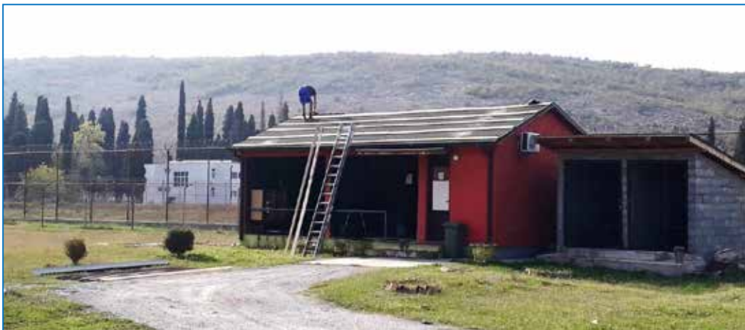
Slika br.32-Zamijenjen krov na objektu za smještaj službenih pasa i adaptirana prostorija za boravak službenika
