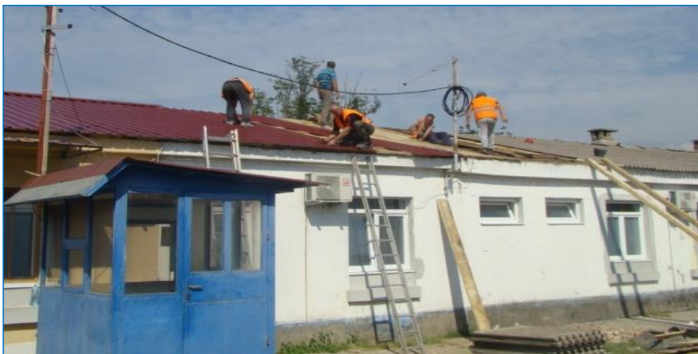
Slika br.33-Objekat u kojem su smještene kancelarije Sektora za rad, kantina, magacir vodovodnog, elektro i građevinskog materijala temeljno adaptiran, zamjenjem krov, kancelarije okrečene, postavljena pvc stolarija
