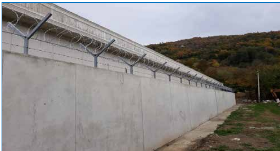
Slika br.41-U saradnji sa opštinama sa sjevera Crne Gore i sredstvima ZIKS-a, realizovan je projekat gradnje bedemskog zida, visine 3m u dužini 130m.
