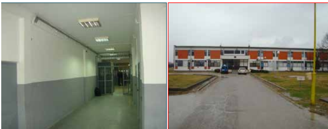
Slike br.29,30-U Zatvoru za kratke kazne ofarbana fasada objekta, hodnici, te metalne ograde unutar objekta
