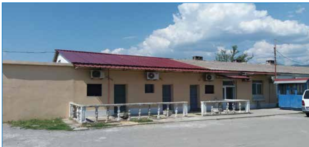
Slika br.37-Zamijenjen krov na objektu za porodične posjete u KPD-u
