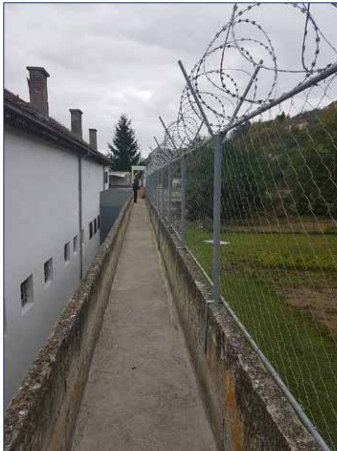
Slika br.45-Postavljena zaštitna mreža na starom bedemskom zidu, visine 2 metra (prvi prsten) iza Zatvorenog i Istražnog odjeljenja, sa žicom na vrhu.
