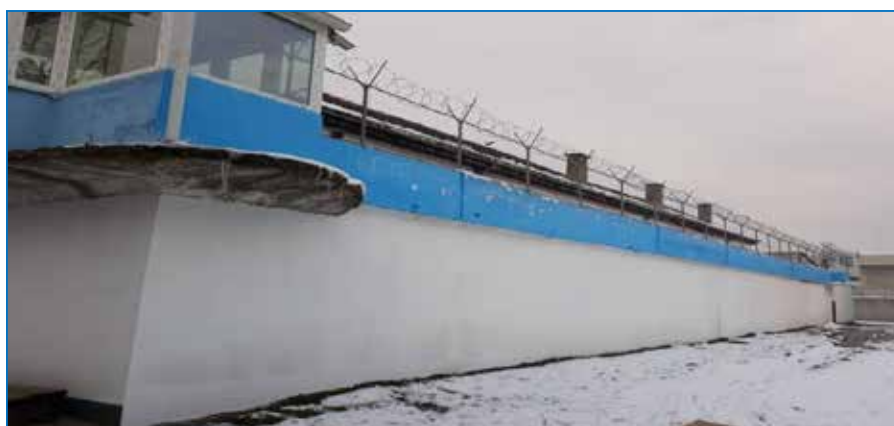
Slika br.43-Postavljena nova stražarsko osmatračka mjesta, SOM 2 i SOM 3 (izgrađena od eloksira). Osmatračnica SOM 2, koja je bila neuslovna, u cjelosti je zamijenjena.
