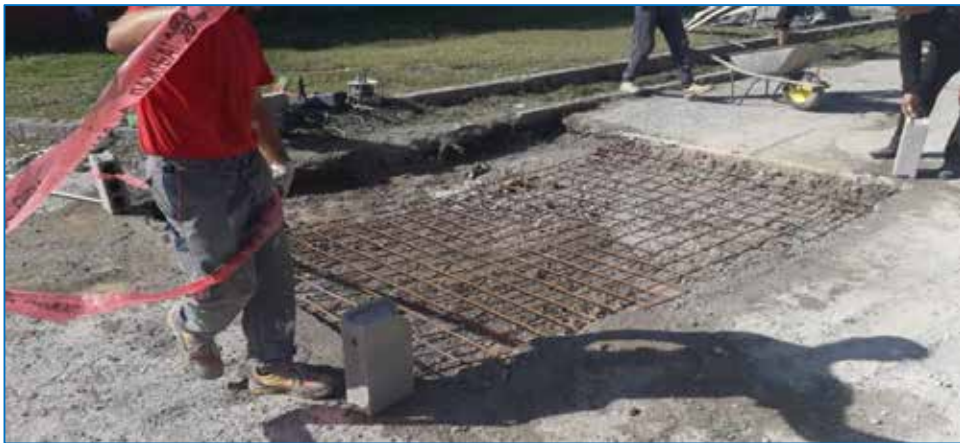
Slika br.39-Izrađena prilazna staza Istražnom zatvoru Podgorica.
