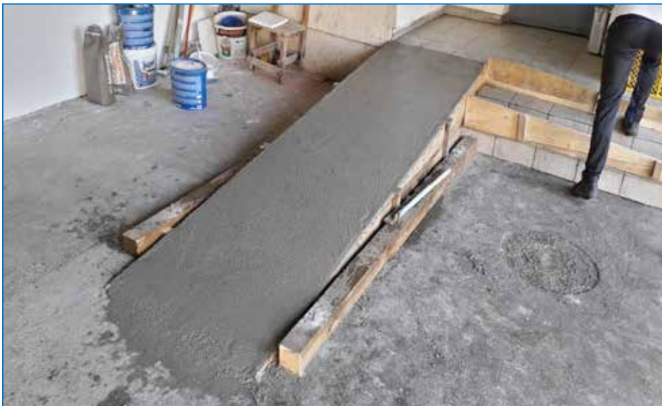
Slika br.40-Izrađna rampa za prilaz osoba sa invaliditetom u "F" paviljonu KPD-a.
