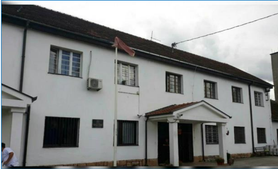
Slika br.52-Završeni molersko farbarski radovi na fasadi zgrade i komplet spoljašnjim zidovima ukupne površine oko 1.000m 2 (maltanje i krpljenje zidova i nanošenje lijepka i mrežice na jednom dijelu zida, krečenje, odvajanje jednog dijela zida u boji)
