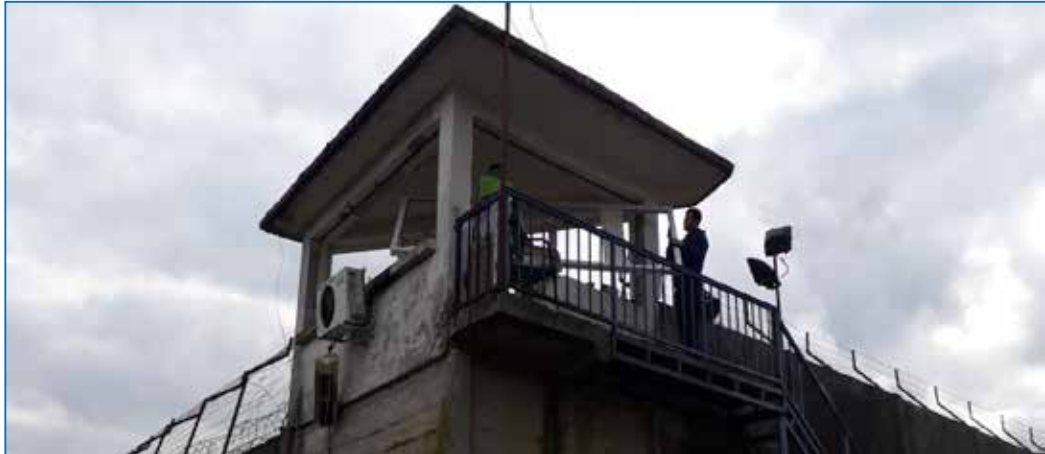
Slika br.38-Postavljena PVC stolarija na stražarsko osmatračkom mjestu u KPD-u.
