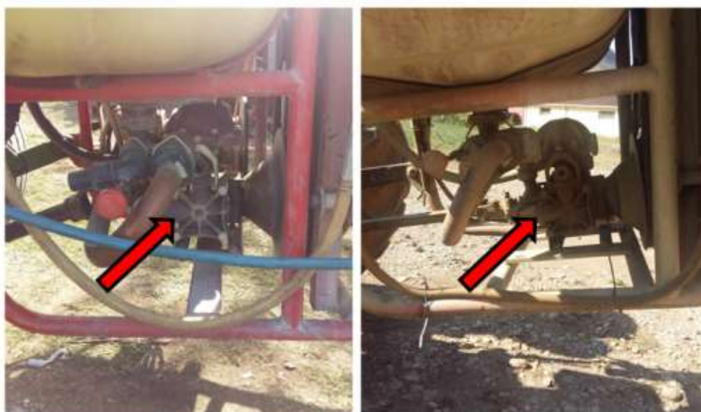
Slika 10. Prikaz pumpi za vodu, lijevo lokacija Golubovci, desno lokacija Lješkopolje
