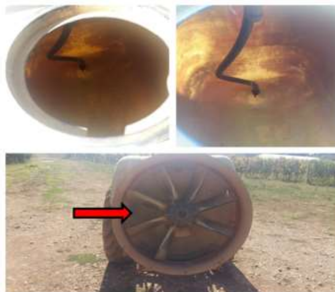
Slika 2. Nezadovoljavajuće stanje unutrašnjosti rezervoara i nepostojanje zaštitne mreže ventilatora
