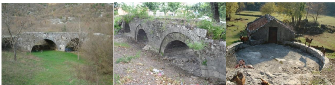
Mostovi i Guvno sa slammicom
