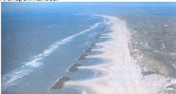
Slika 46: Primjer zaštite obale od erozije izgradnjom odvojenih lukobrana
