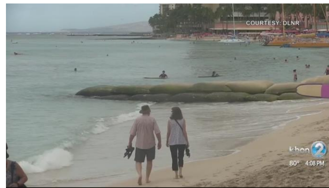
Slika 48: Naperi od vreća sa peskom na plaži Vaikiki na Havajima
