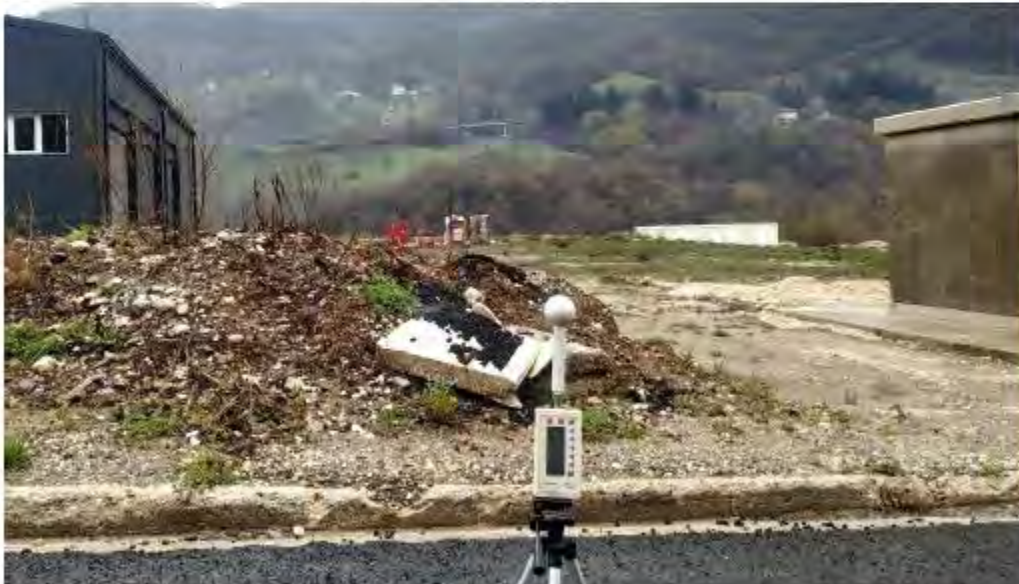
Слика 2. Фотографија мјерног мјеста број 1 (MT1) изабрано на платоу предвиђеном за изградњу траfoстанике напонског нивоа 35/110 kV/kV са координатама MT1 (43°25'50.20"N 18°45'41.25"E) у односу на околину
