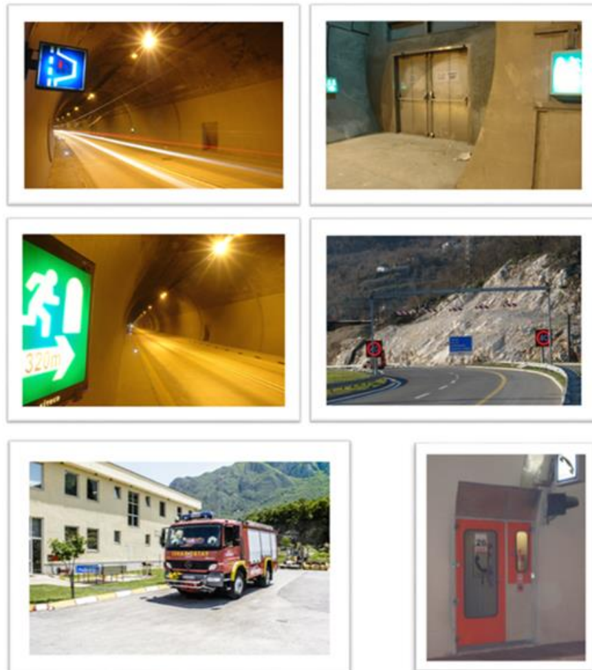
Slika 8. Oprema u tunelu Sozina (izvor: www.http://monteput.me/ )
