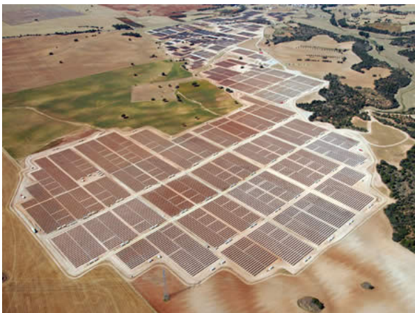
Slika: Solarna elektrana Olmedilla
