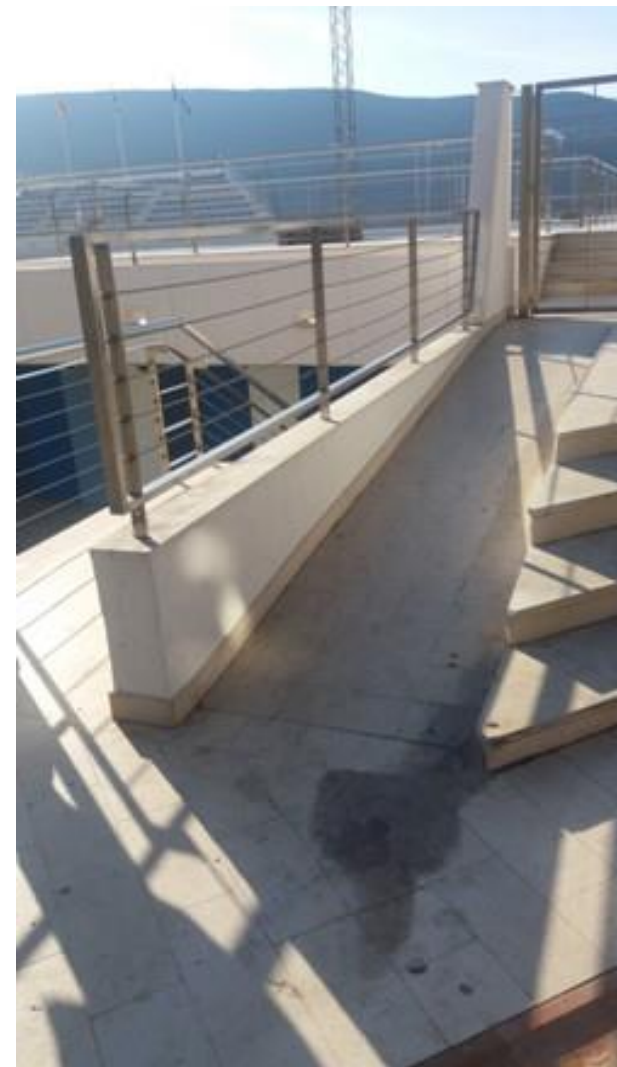
Slika 36. Prilazna rampa – bazen na Škveru
