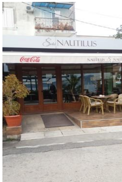
Slika 17. Prilazna rampa ugostiteljskom objektu u Igalu
