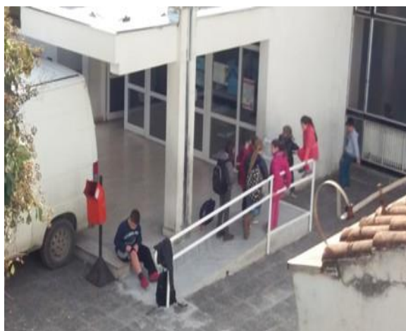
Slika 33. Prilazna rampa na OŠ Milan Vuković
