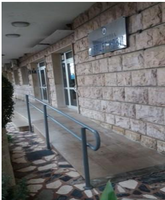
Slika 4. Prilazna rampa glavnom ulazu zgrade Opštine Herceg Novi
