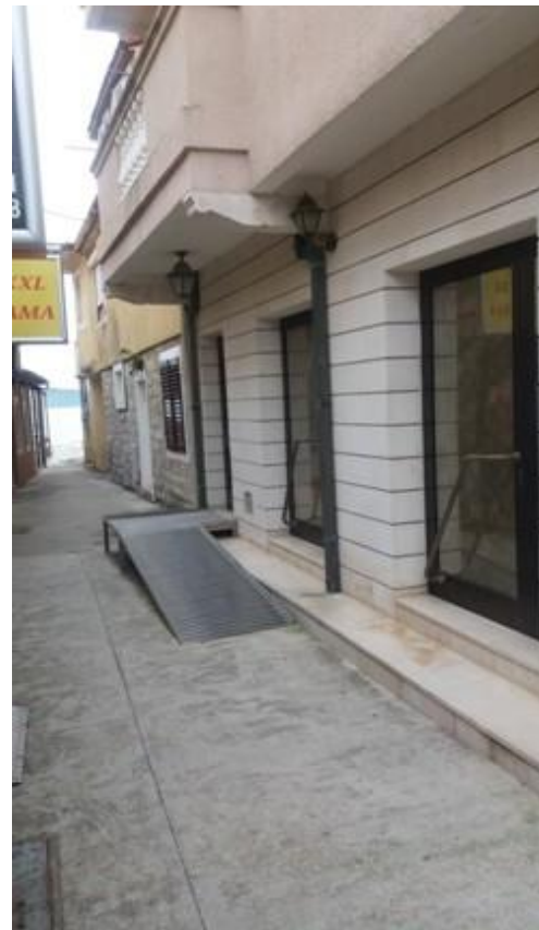
Slika 13. Prilazna rampa ispred stambeno-poslovnog objekta u Igalu
