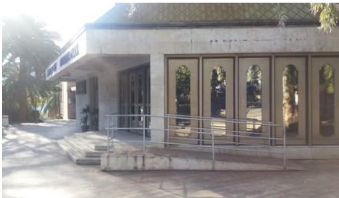
Slika 30. Prilazna rampa na ulazu u Dvoranu Park
