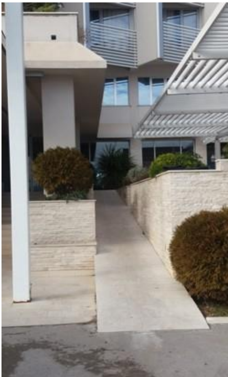
Slika 49. Pristupna rampa na turističkom objektu u Bijeloj
