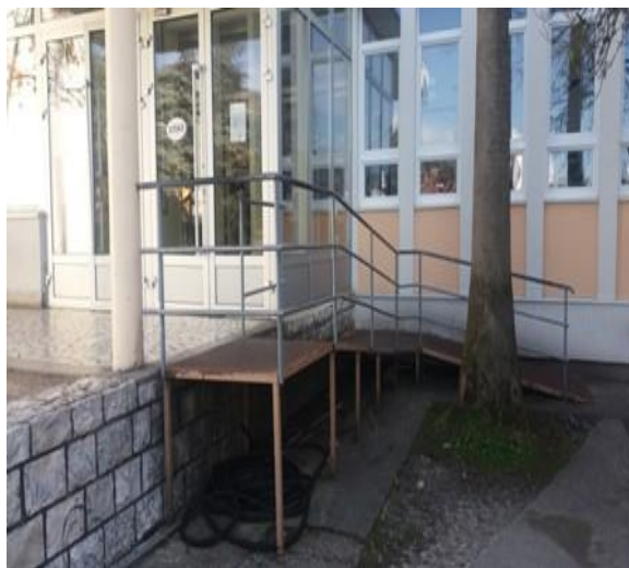
Slika 31. Prilazna rampa na OŠ Dašo Pavičić
