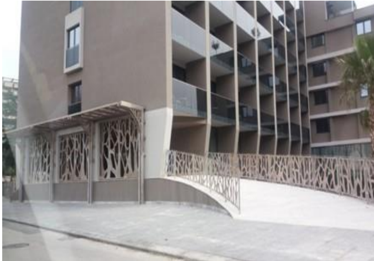
Slika 48. Pristupna rampa na turističkom objektu u Igalu
