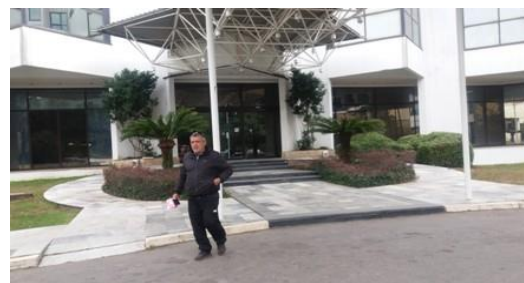
Slika 10. Prilazne rampe – Institut dr. Simo Milošević II faza
