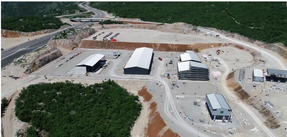
Slika 9. Baza za održavanje, kontrolu i upravljanje autoputa
