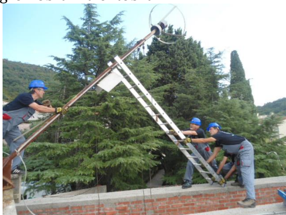
Slika 16 Uklanjanje gromobrana sa hotela Castellastva u Petrovcu
