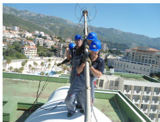
Slika 17 Uklanjanje gromobrana sa hotela Mediteran u Bečićima
