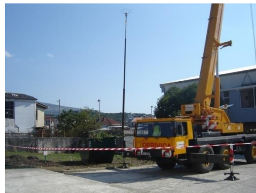
Slika 3 Uklanjanje gromobrana sa OŠ „Maršal Tito“ u Ulcinju
