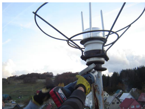
Slika 19 Uklanjanje gromobrana sa stambene zgrade na Žabljaku
