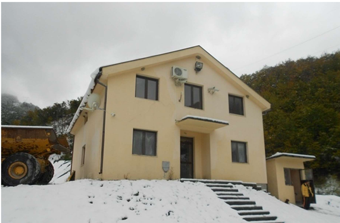
Fotografija poslovne zgrade preduzeća „CRNAGORAPUT“ a.d. Podgorica (Preduzeće u sastavu koncerna „STRABAG SE“) u zoni asfaltne baze.
