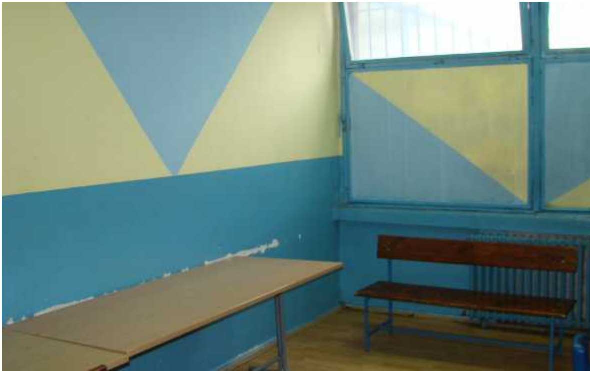
Sala za posjete sa djecom u Istražnom zatvoru prije renoviranja
