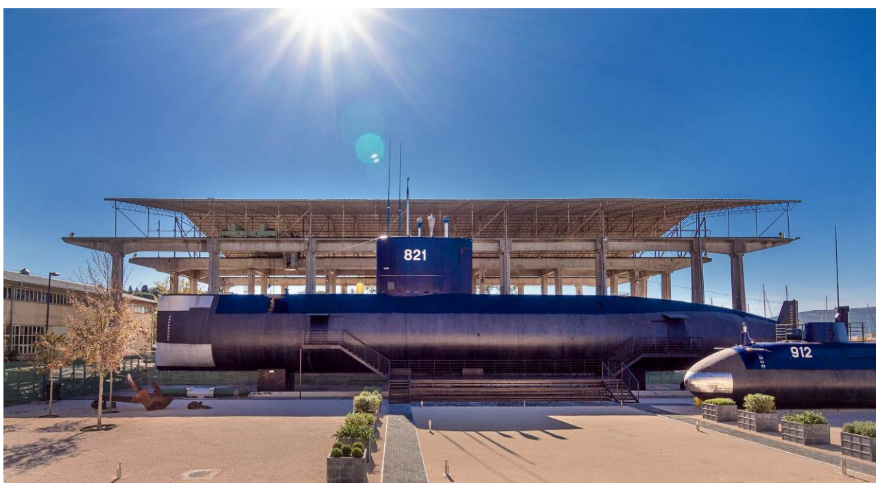
Slika 15: Nadstrešnica sinhro lifta i podmornica P821
