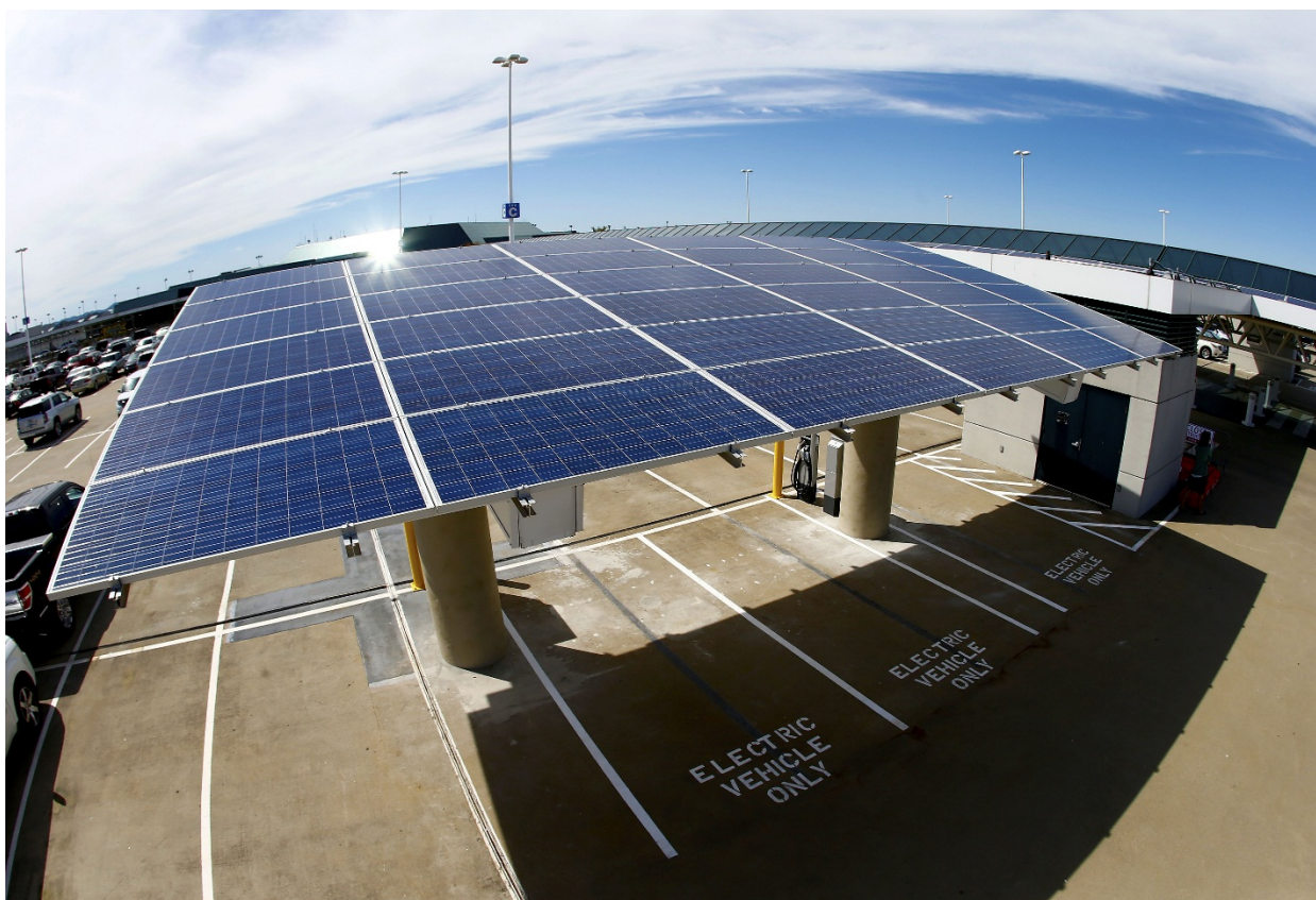
Slika 2: Fotonaponski sistem na parkingu
