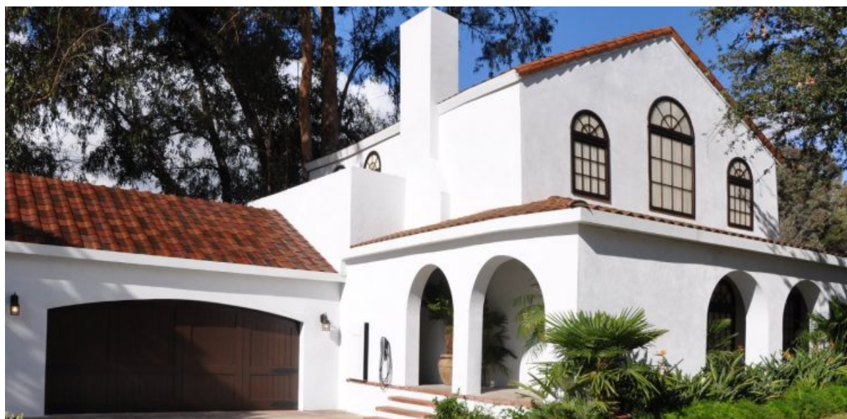
Slika 7: Izgled „solarnog krova“ na objektu
