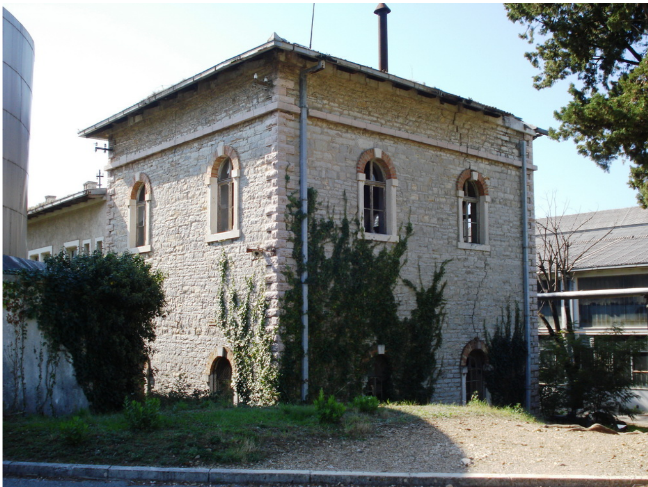
Slika 16: Vojno kupatilo – izgled objekta prije demontaže
