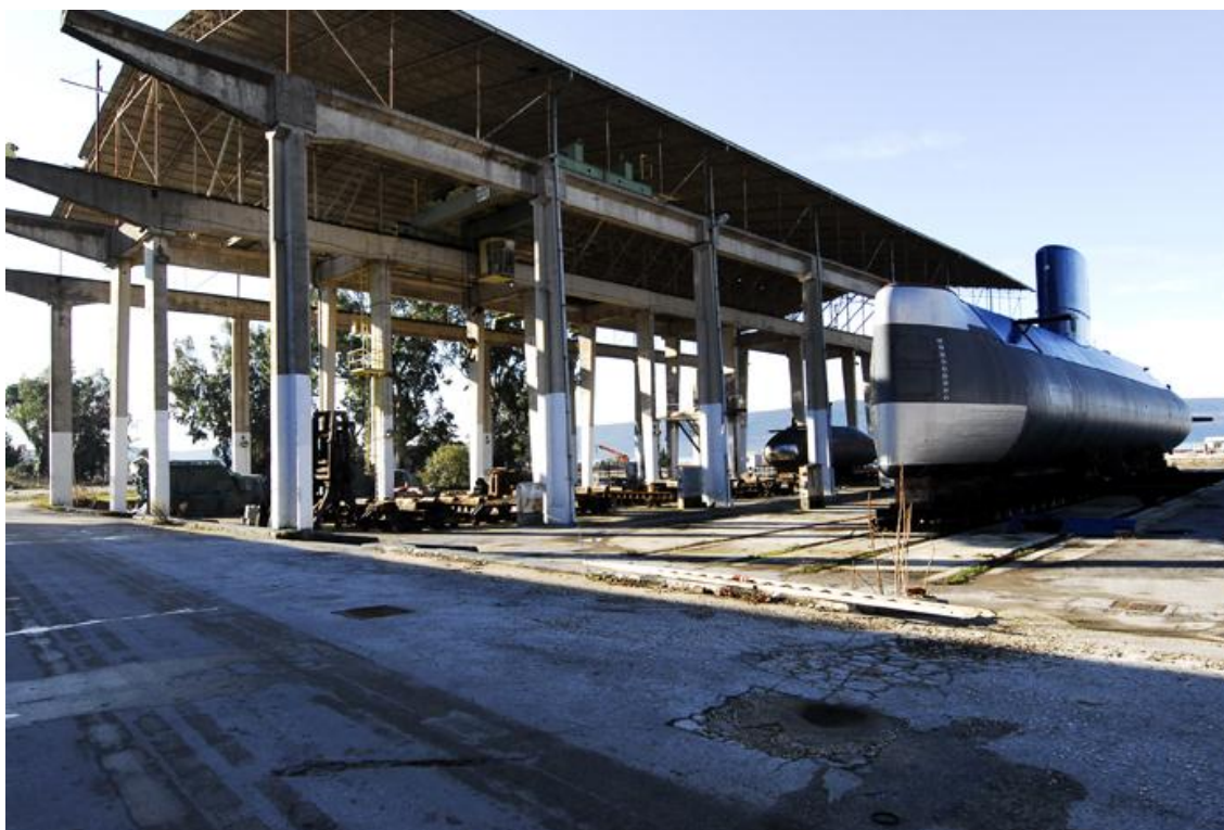
Nastrešnica sinhron lifta i podmornica P821
