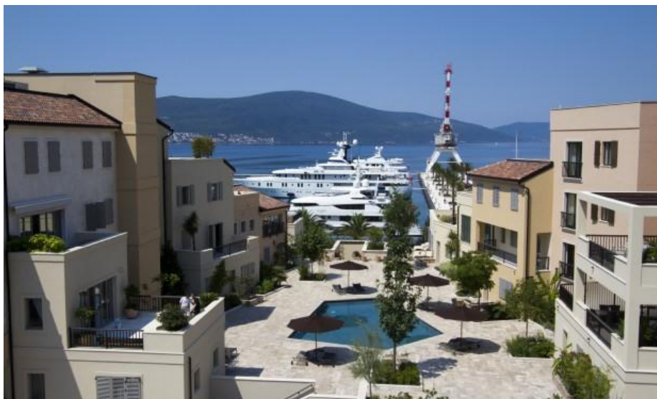
Karakteristični ambijent jednog objekta u naselju Porto Montenegro
