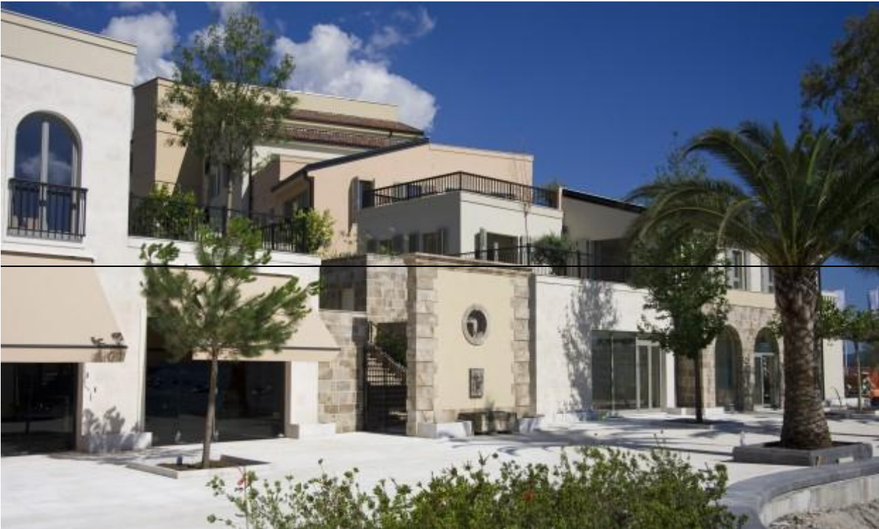
Objekat TEUTA - Karakteristična arhitektura naselja Porto Montenegro
