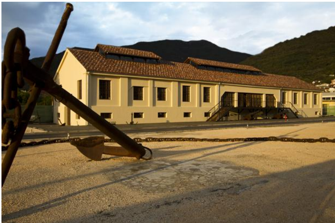
Rekonstruisana zgrada pilane-sada Muzej nautičkog naslijeđa u sklopu kompleksa Porto Montenegro
