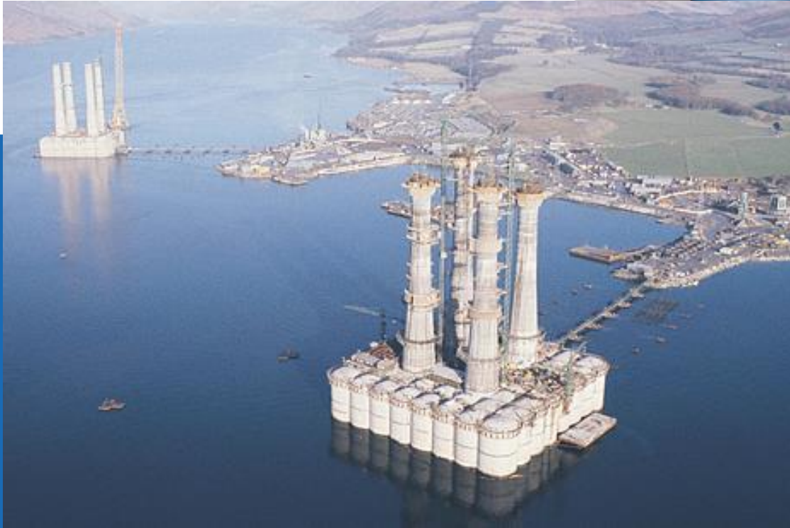
Slika 12. Betonska produkciona platforma
