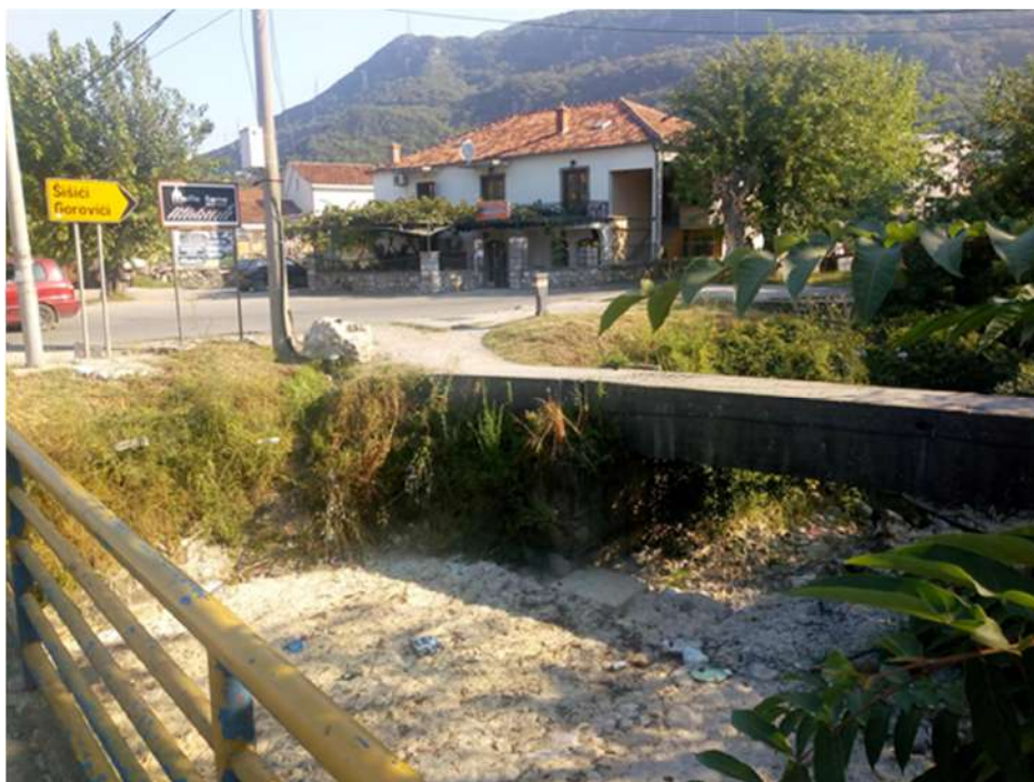
Slika 1. Lokacija 1 Kanal rijeke Drenovštice
