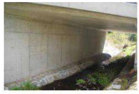
Slika 42. Primjeri propusta koji omogućavaju prolaz akvatičnim i kopnenim životinjama (prema SETRA 2005, Iuell i sar., 2003 i Hahn 2015).
