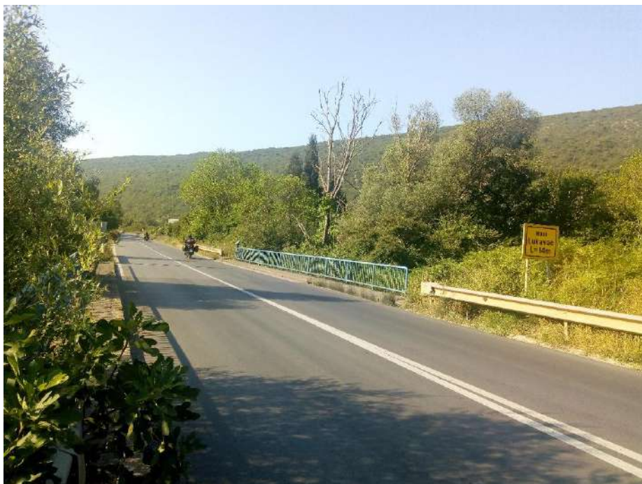
Slika 5. Lokacija 3. Most Lukavac, vodotok Pakočica
