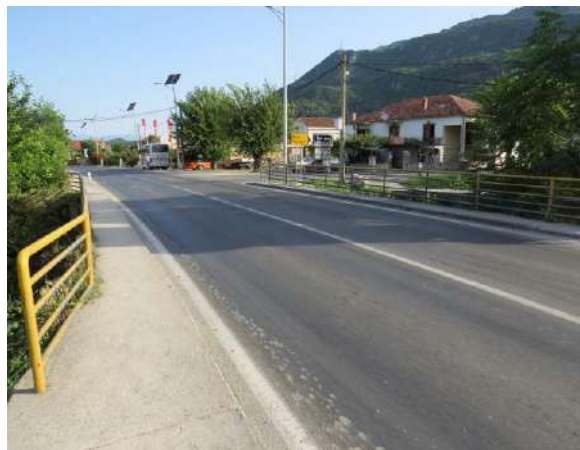
Slika 3. Most na vodotoku Drenovštica
