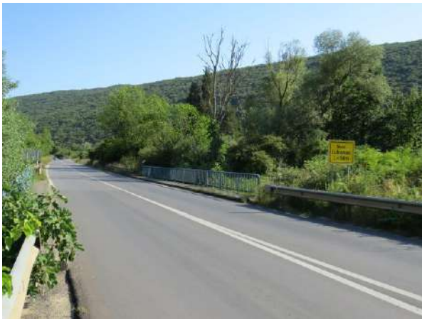
Slika 9. Most na vodotoku Lukavac
