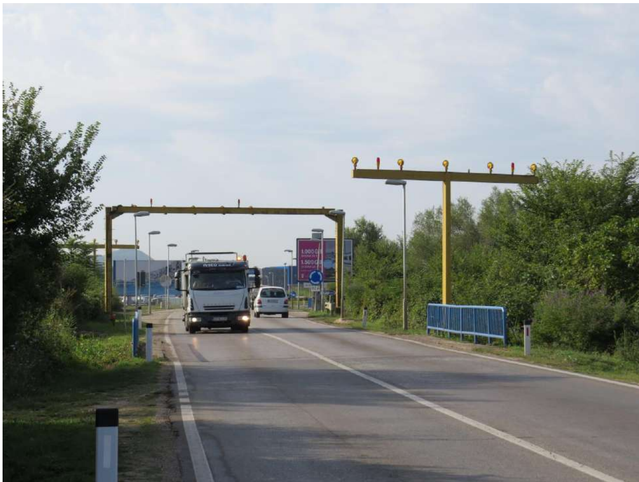
Slika 15. Most Gradiošnica i Vodolježnica
