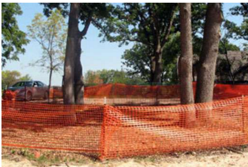
Slika 5: Način zaštite stabala u toku izvođenja građevinskih radova
