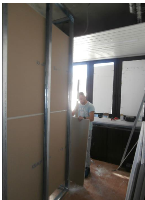
Sl. 4. Postavljanje nosača zidova i prostora za izolaciju
