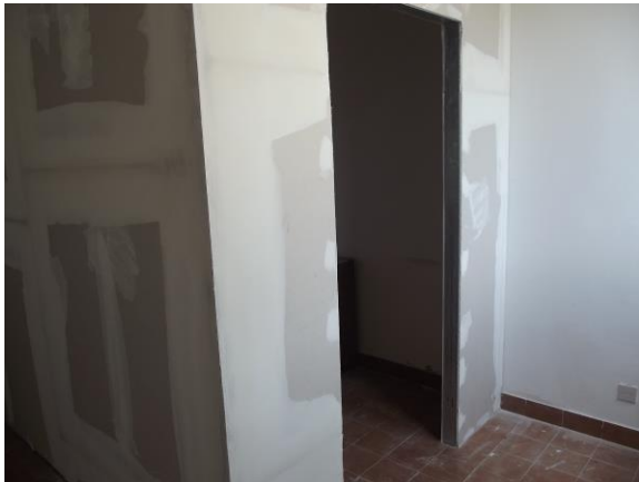
Sl. 4. Pregrađeni dio sa izolovanim zidovima
