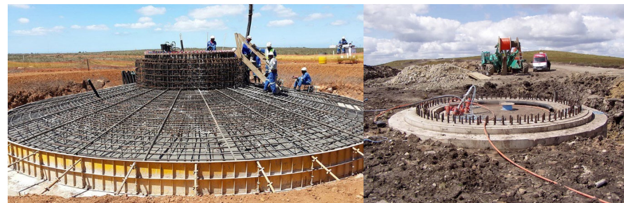
Primjeri temelja vjetroturbina
