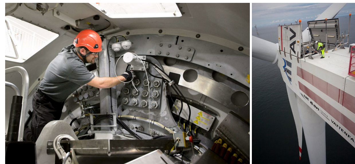
Preventivno održavanje vjetroturbine
