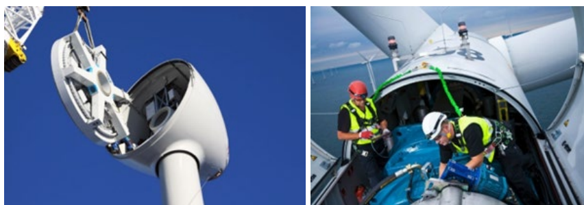
Primjeri montiranja dijelova opreme na gondoli
