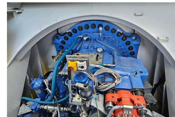
Povezivanje generatora vjetroatregata
