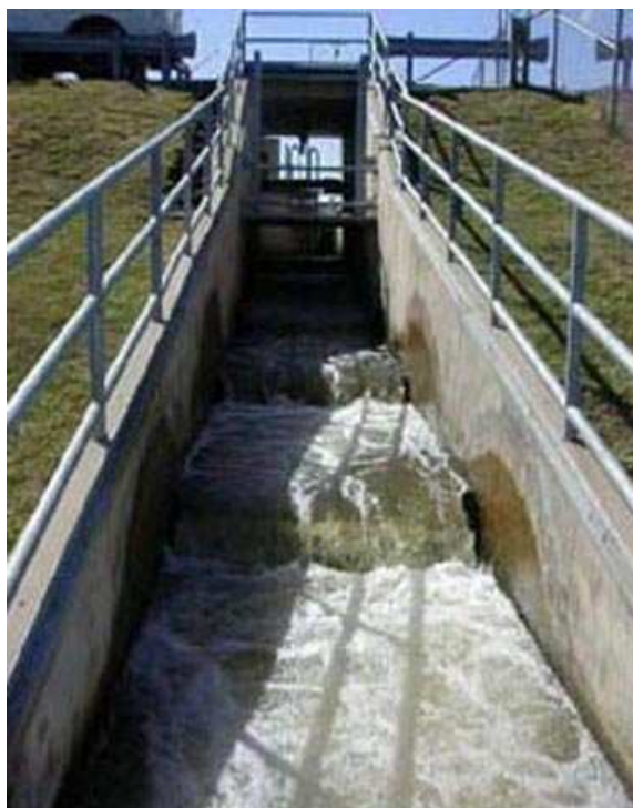
Слика 61 Преводнице од базена и брана (на брани „Berien Springs“, ријека Ст. Џозеф, УСА)
