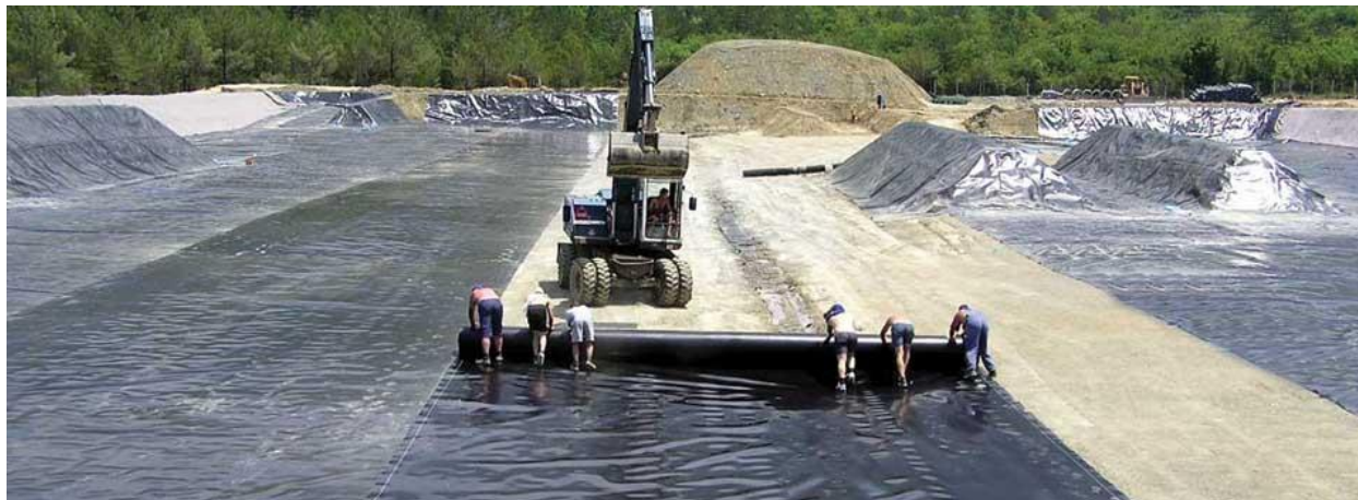
Slika 5. Prikaz procesa izgradnje deponije Možura
