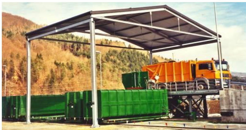
Slika 30. Pretovarna platforma sa nadstrešnicom
