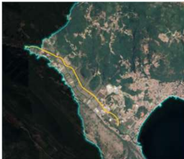
Slika 4.3. Dionica Sutorine na kojoj su izvođeni regulacioni radovi
