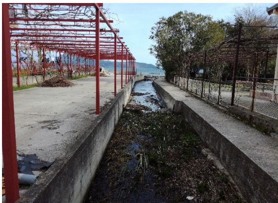
Potok "2", izbetonirano korito kanalisano između dva privatna imanja i njegovo ušće sa rešetkom
