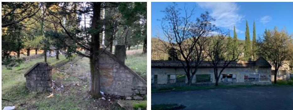
Fotografije postojećih objekata
